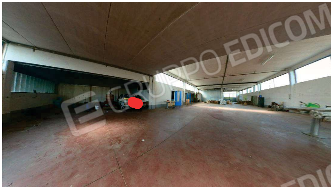
Foto 04 – Laboratorio Artigiano – Vista Interna
