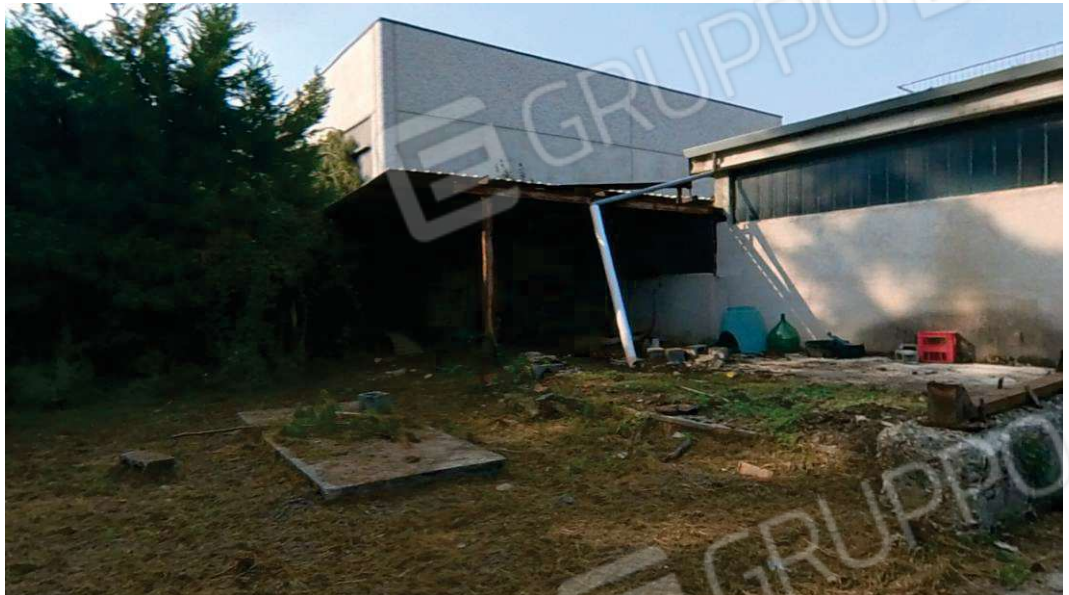
Foto 26 – Cortile Posteriore e Tettoia
