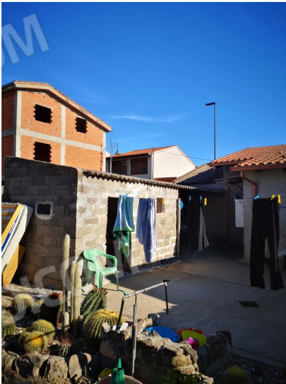
Foto 47 Vista locali di sgombero 2 e 3 da cortile
