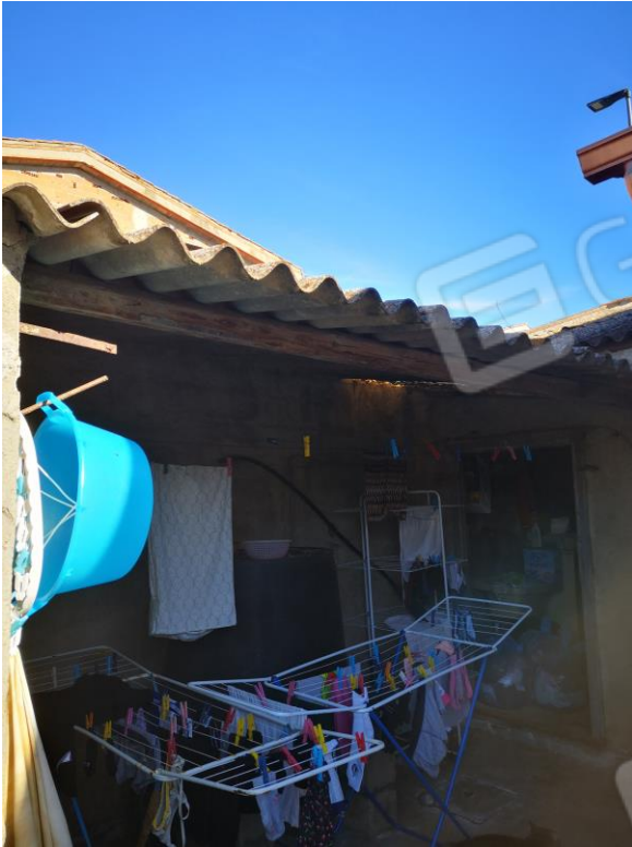
Foto 45 Vista interna tettoia
