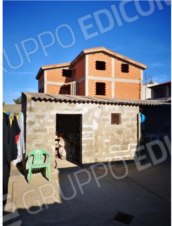
Foto 46 Vista locali di sgombero 2 e 3 da cortile
