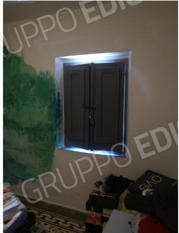
Foto 22 Vista interna camera 2
