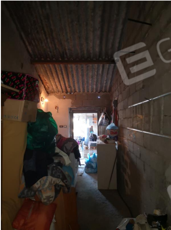
Foto 41 Vista interna garage
