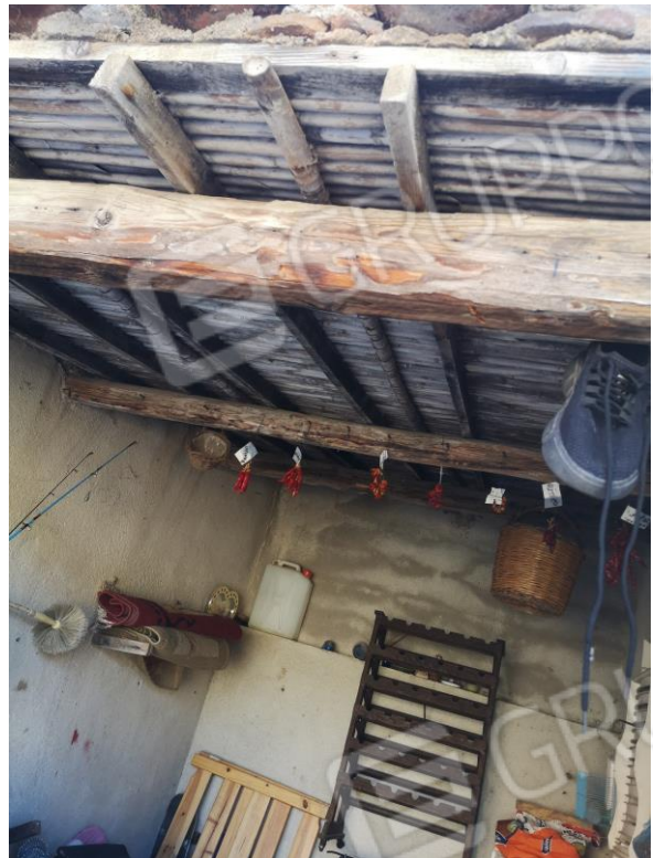
Foto 56 Vista interna locale sgombero 1
