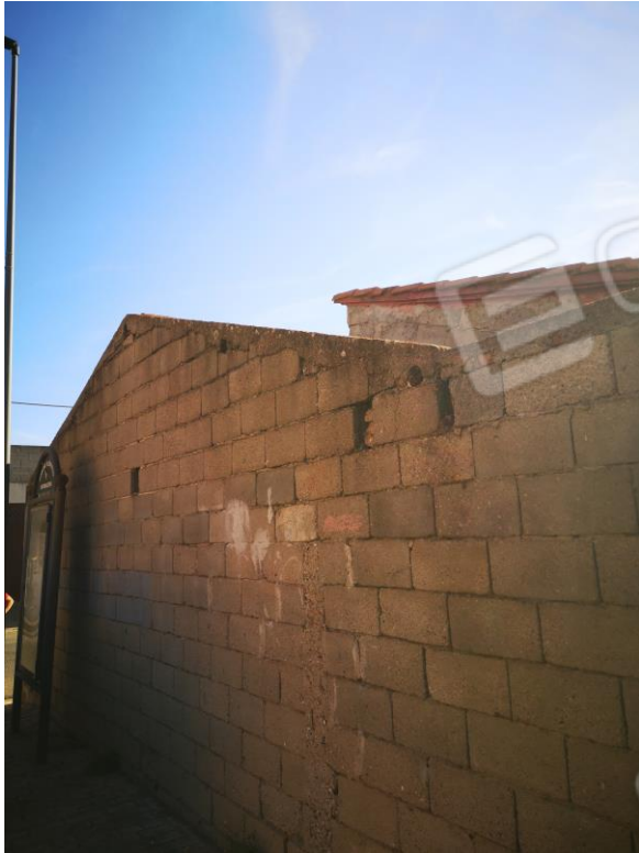
Foto 5 Vista prospetto laterale da Via San Francesco
