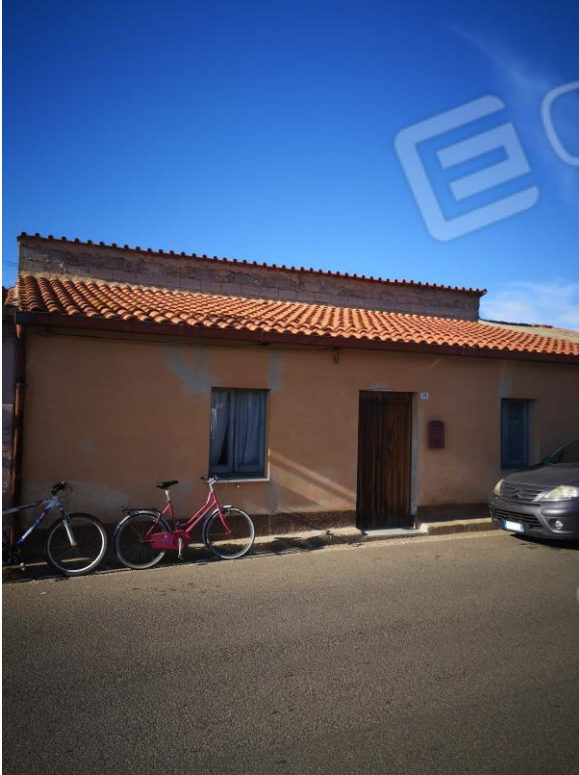
Foto 1 Vista prospetto frontale da Via P. Umberto
