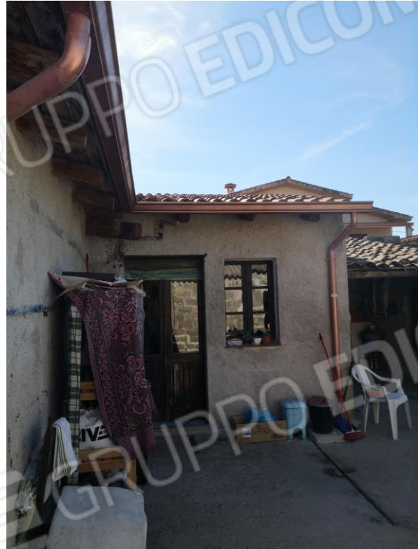
Foto 10 Vista prospetto posteriore da cortile interno
