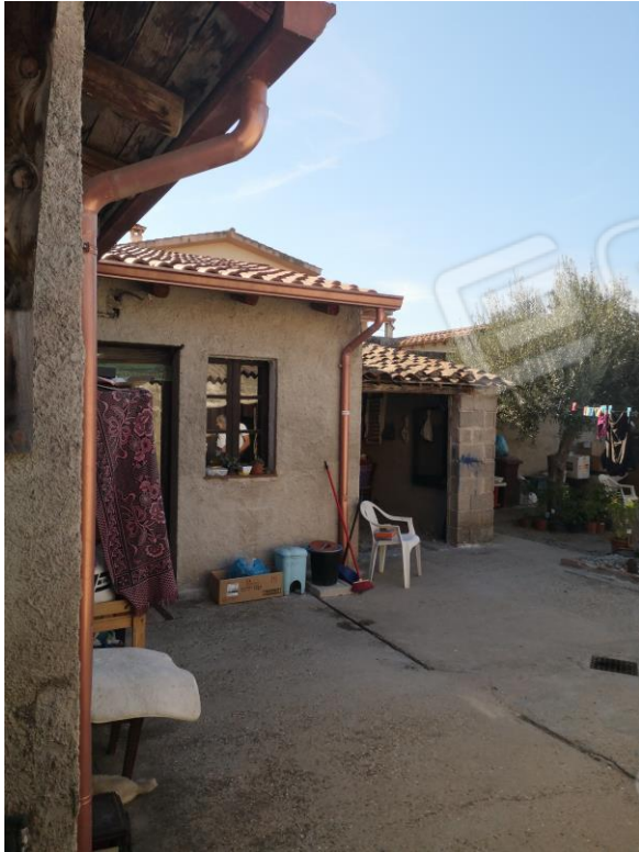
Foto 9 Vista prospetto posteriore da cortile interno
