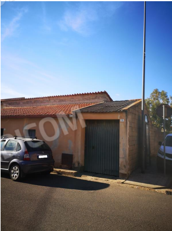
Foto 3 Vista prospetto frontale da Via P. Umberto
