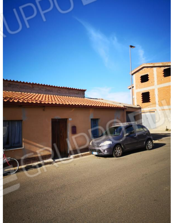
Foto 2 Vista prospetto frontale da Via P. Umberto
