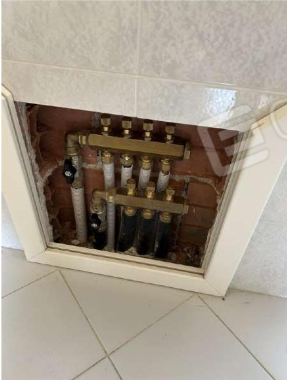
Foto 137 Particolare centraline impianto termico e idrico
