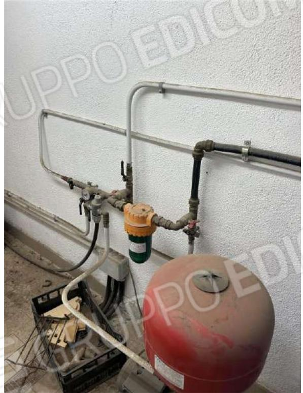
Foto 142 Particolare autoclave per acqua sanitaria
