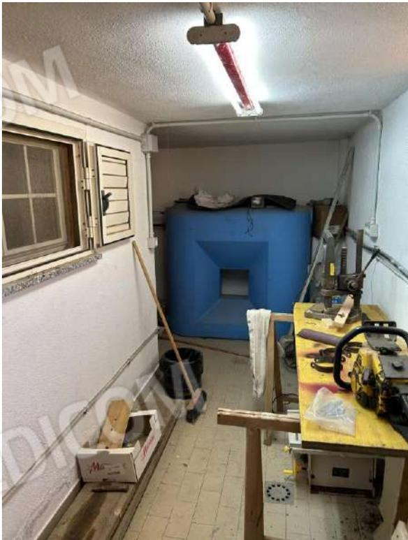
Foto 143 Particolare cisterna impianto idrico
