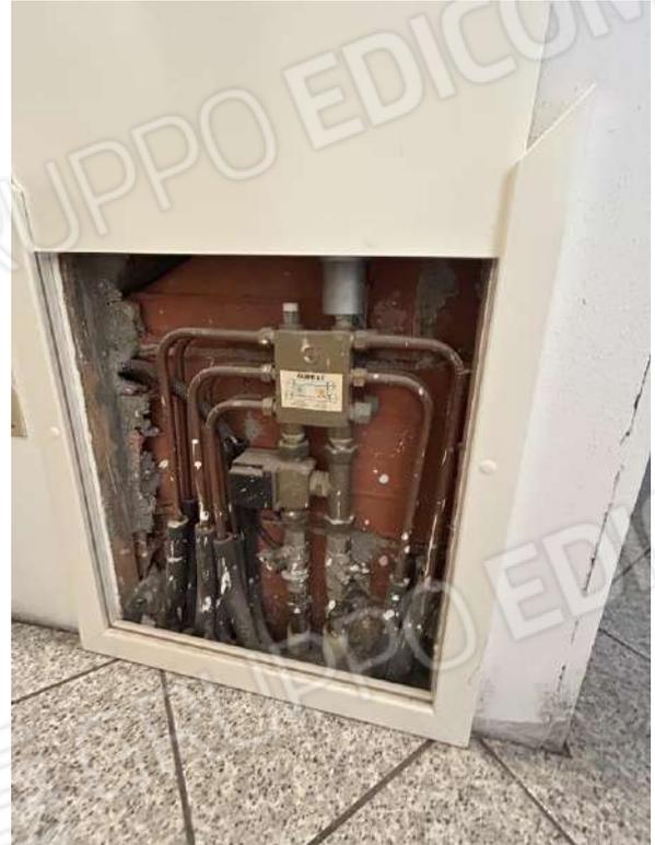
Foto 138 Particolare centraline impianto termico e idrico
