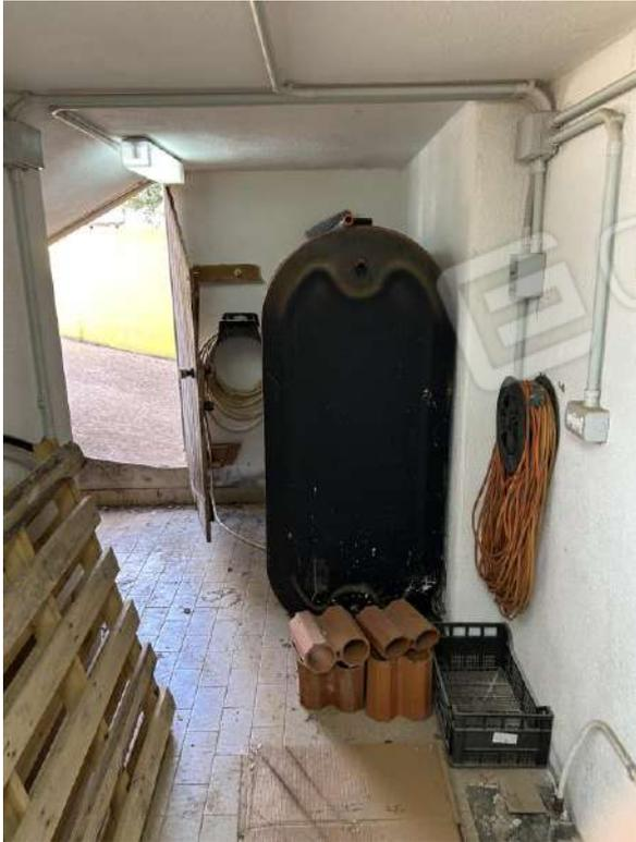
Foto 141 Particolare cisterna gasolio impianto termico
