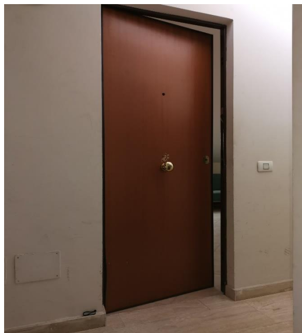
Foto n. 4 Porta di ingresso appartamento
