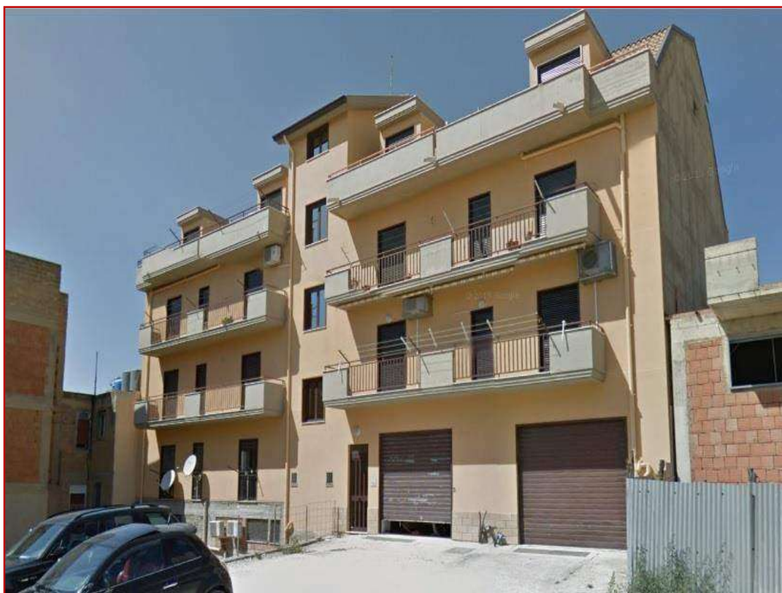
Foto 2 – Vista Complesso Edilizio – Lato SUD
