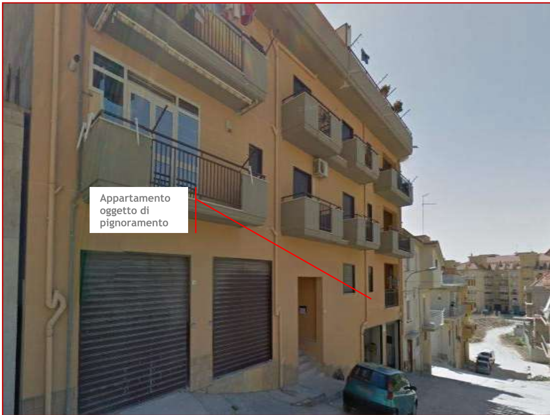
Foto 1 – Vista Complesso Edilizio – Lato Nord
