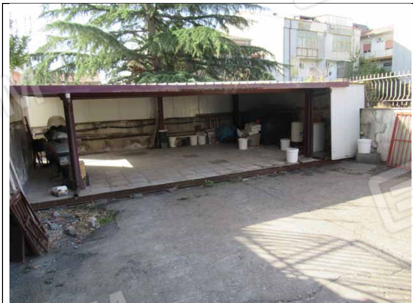
foto n° 24: Tettoia aperta sul cortile antistante il garage
