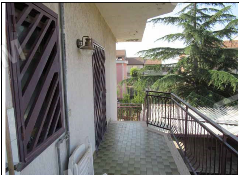
foto n° 21: Vista del ballatoio al piano terra lato ovest
