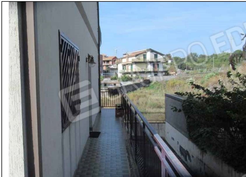
foto n° 10: Vista del ballatoio al piano terra lato nord
