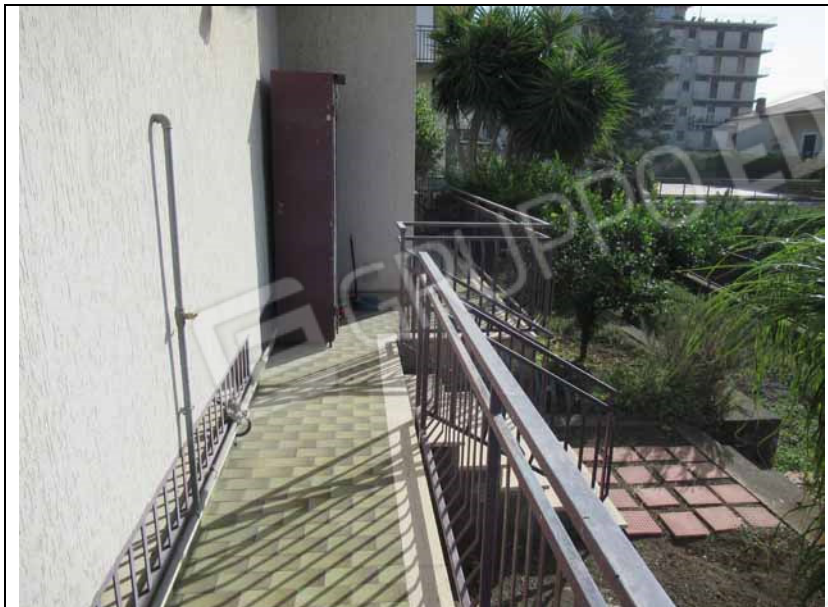
foto n° 22: Vista del ballatoio al piano terra lato sud
