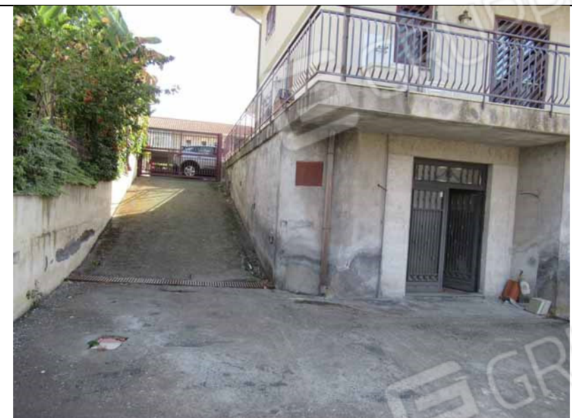
foto n° 5: Ingresso carrabile su Via Quasimodo visto dall'interno
