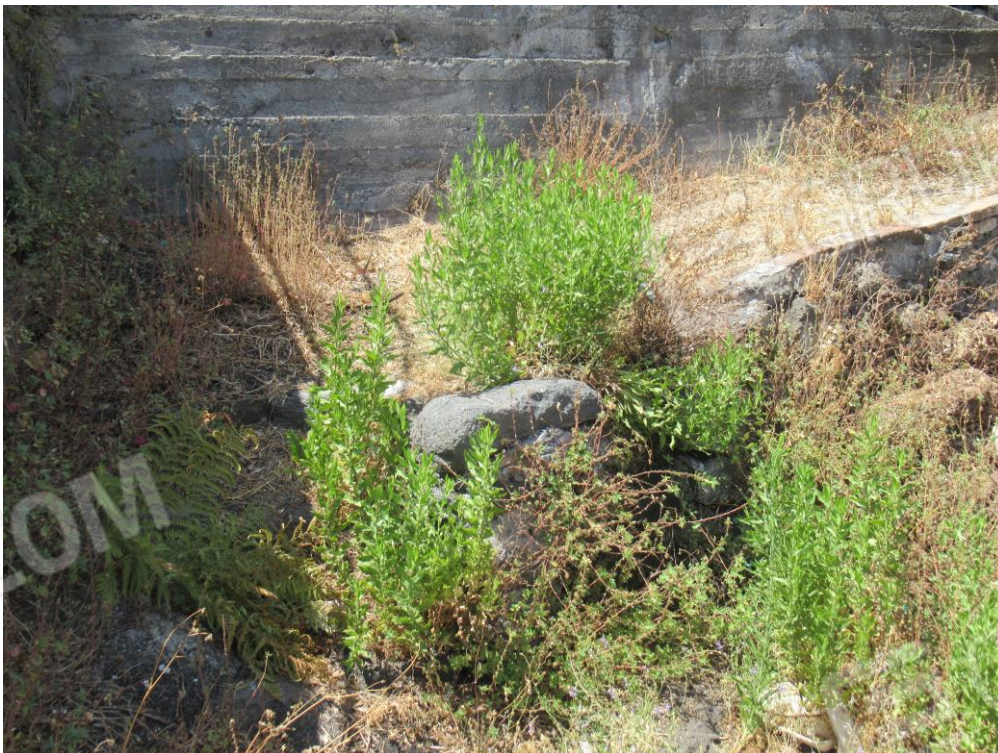
Foto n ° 16 – Zona cortile –
