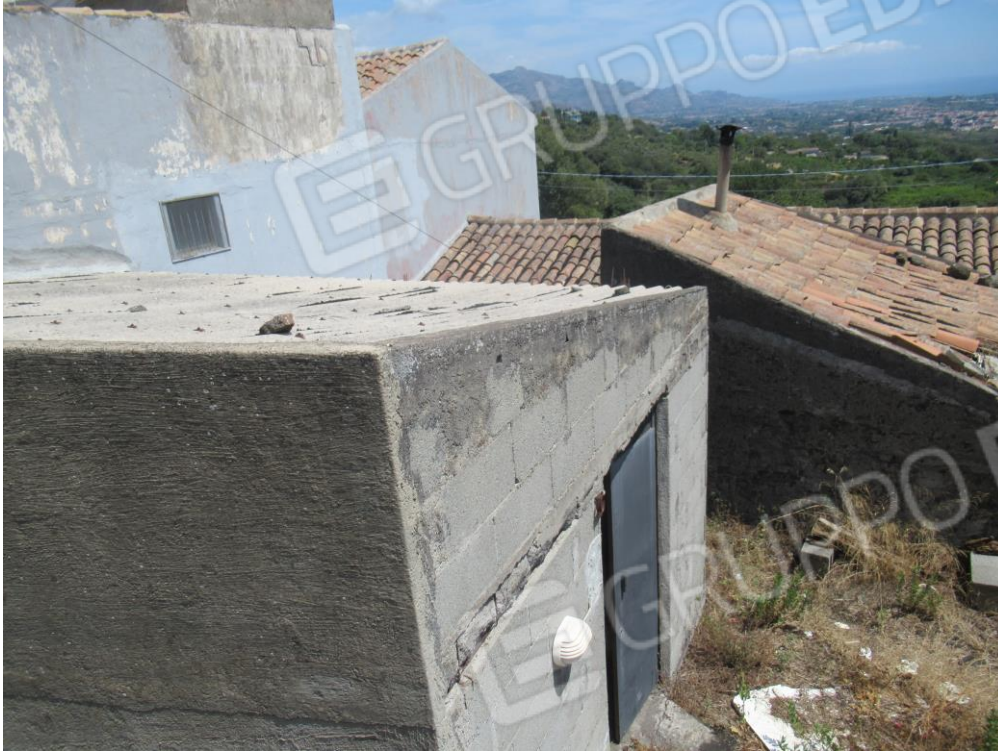
Foto n ° 19 – Zona cortile –
