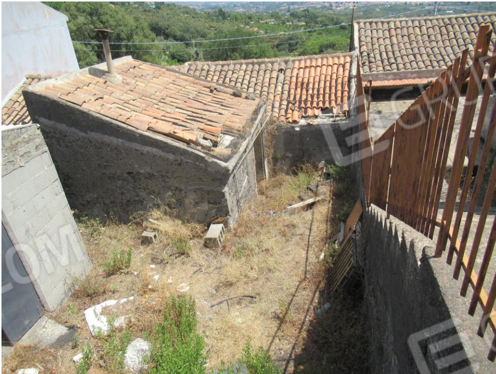
Foto n ° 20 – Zona cortile –
