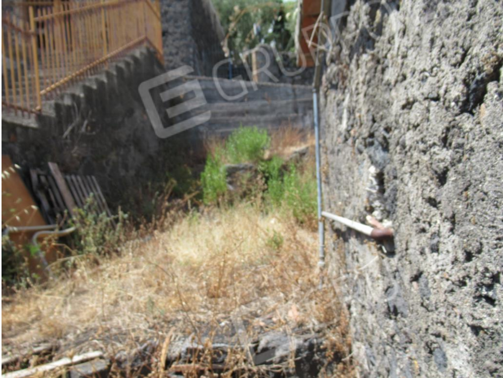
Foto n ° 15 – Zona cortile –
