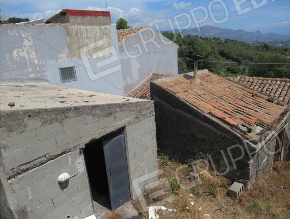
Foto n ° 21 – Zona cortile –
