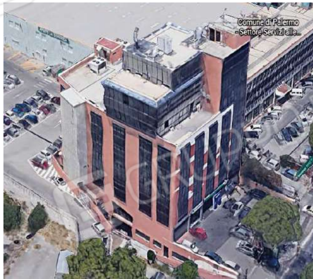
1. Foto aerea dell'edificio
