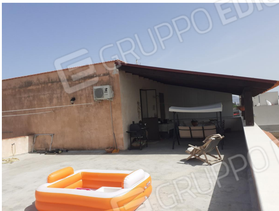
Foto n. 19 Vista della terrazza e della tettoia p.p.
