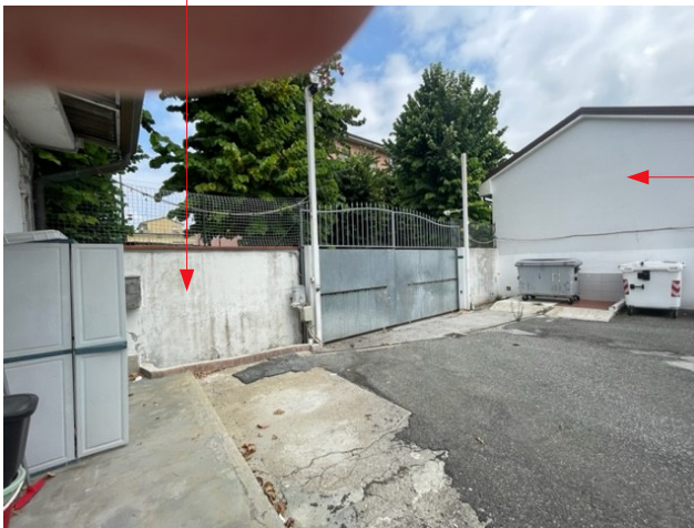
Muro di recinzione di proprietà del compendio immobiliare
