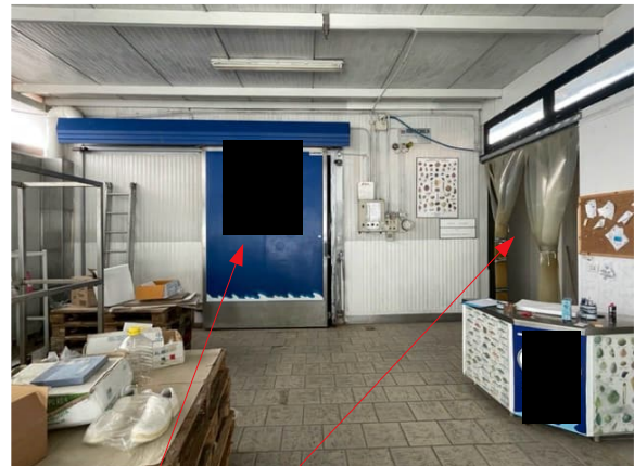
1^ vano ad uso "lavorazione" , con accesso alla cella frigo principale e al 2^ vano ove sono poste le altre 2 celle
