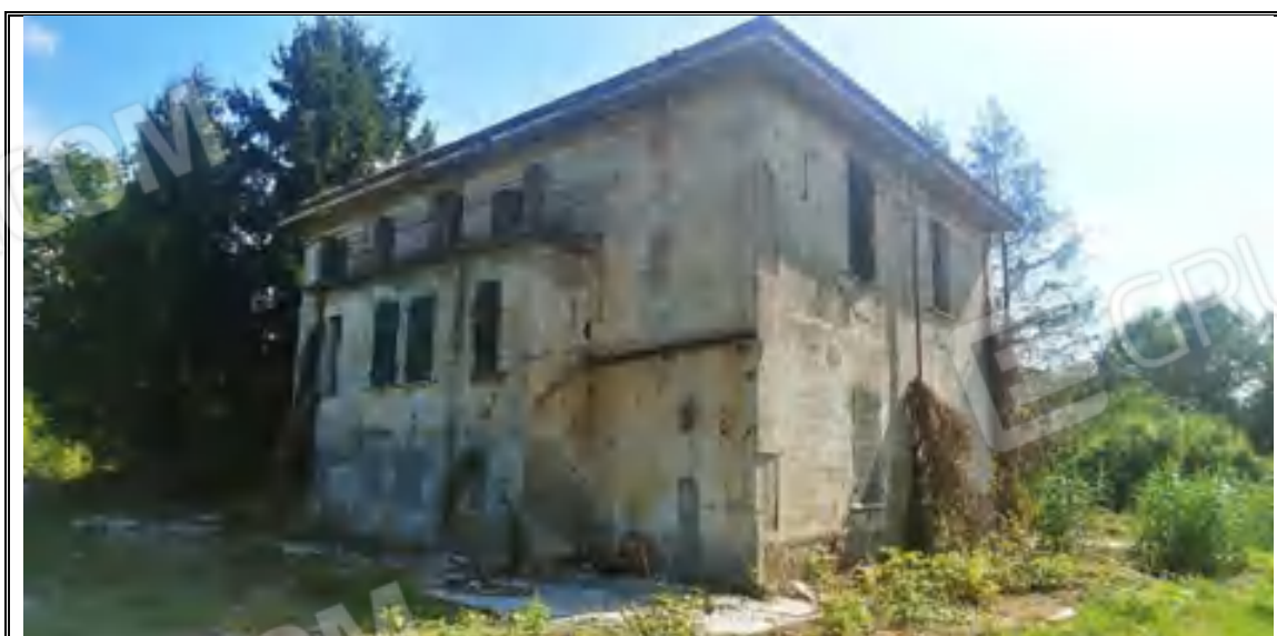
Foto n. 15 – Corpo A - Fabbricato mappale 287 – Angolo OVEST
