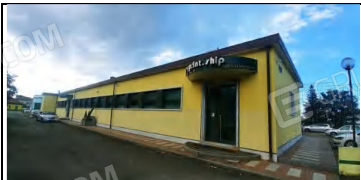
Foto n. 24 – Corpo B – Palazzina uffici mappale 505 – Angolo NORD
