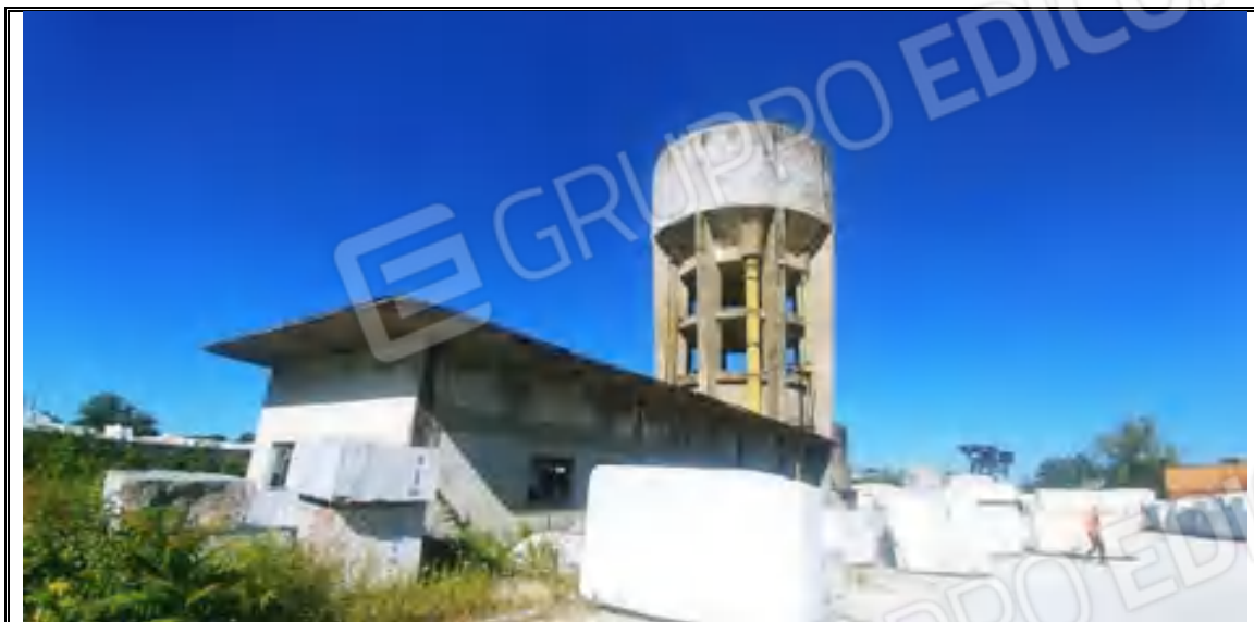
Foto n. 76– Corpo D – Ex stazione pompaggio mappale 470 – Angolo EST
