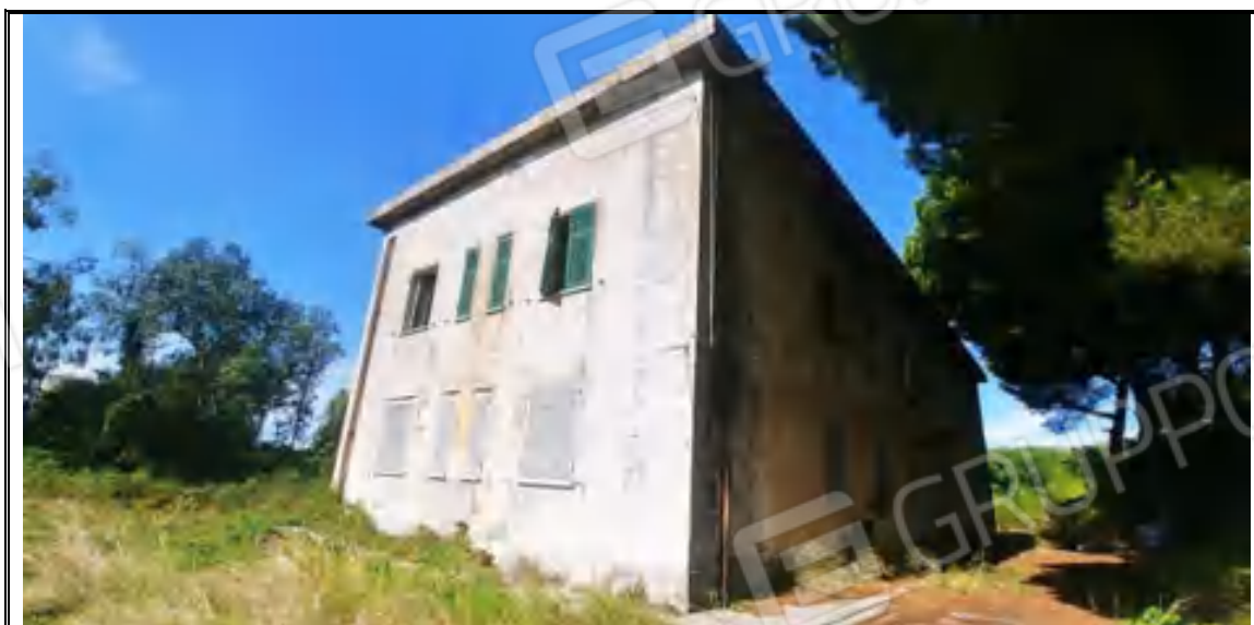
Foto n. 8 – Corpo A - Fabbricato mappale 282 – Angolo EST
