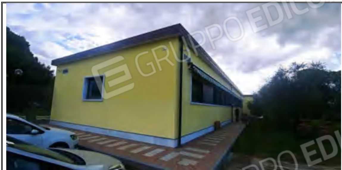
Foto n. 25– Corpo B – Palazzina uffici mappale 505 – Angolo OVEST
