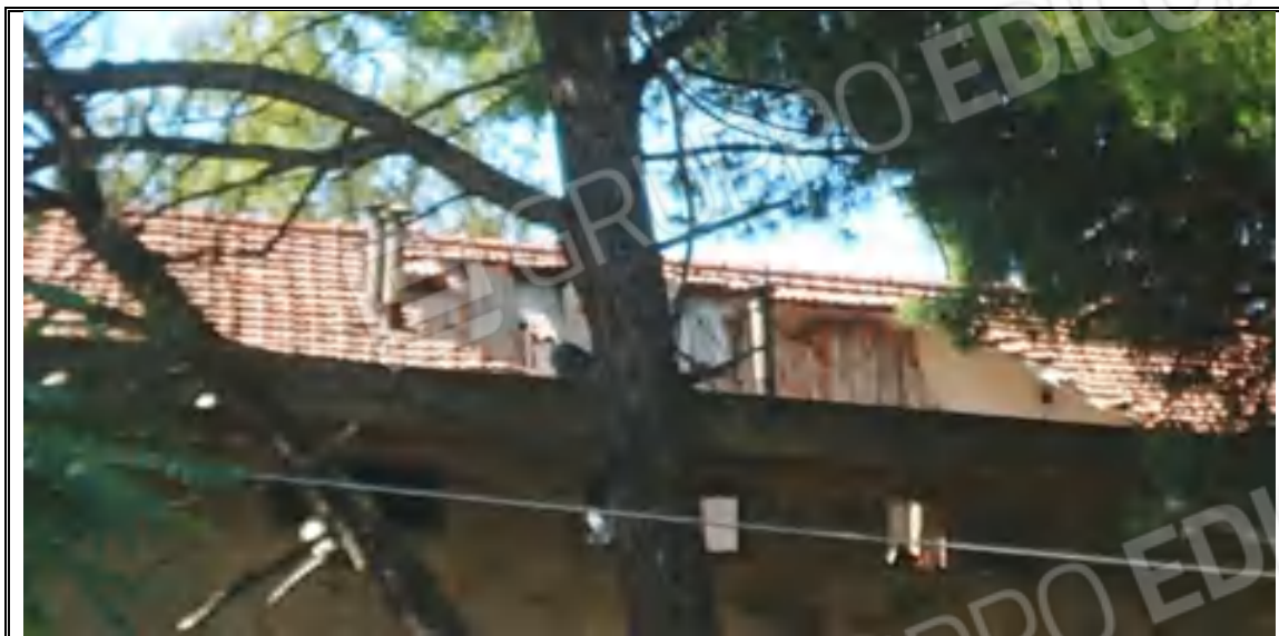
Foto n. 13– Corpo A - Fabbricato mappale 282 – Vista del tetto
