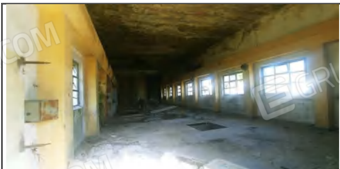
Foto n. 81 – Corpo D – Ex stazione pompaggio mappale 470 – Interno
