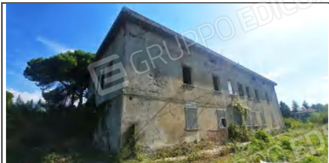
Foto n. 10– Corpo A - Fabbricato mappale 282 – Angolo OVEST
