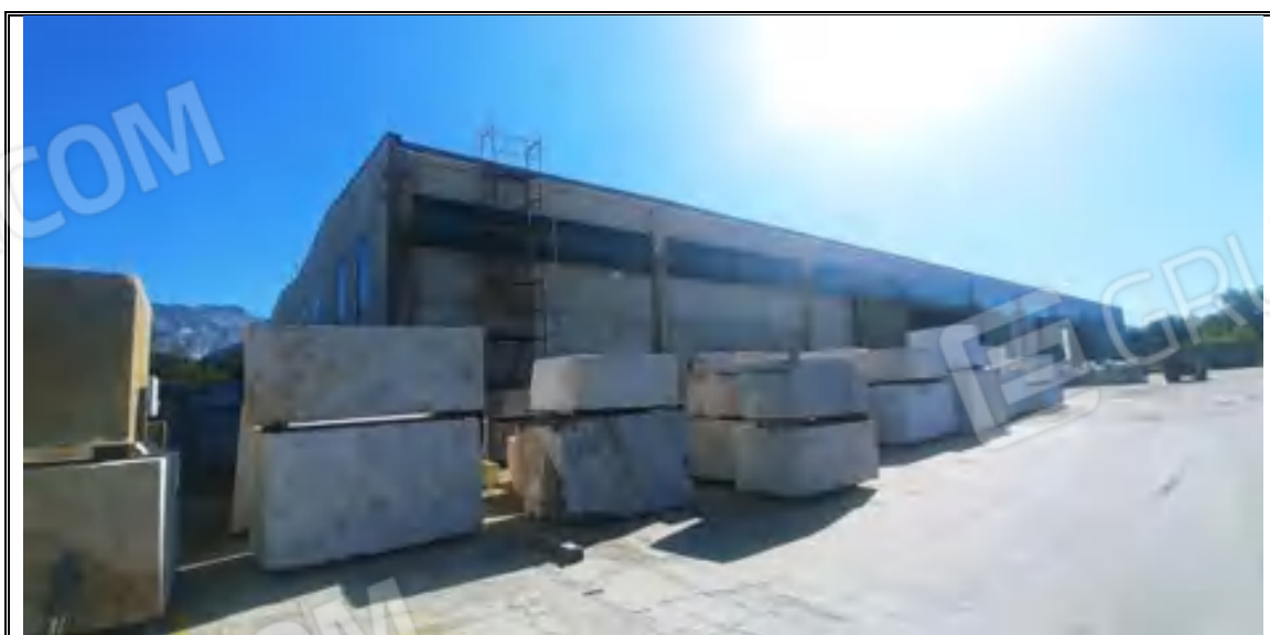
Foto n. 57 – Corpo C – Capannone mappale 547 – Angolo OVEST
