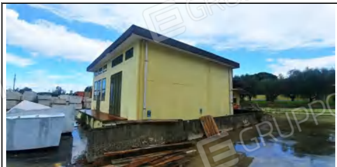
Foto n. 50– Corpo C – Magazzino mappale 548 – Angolo SUD
