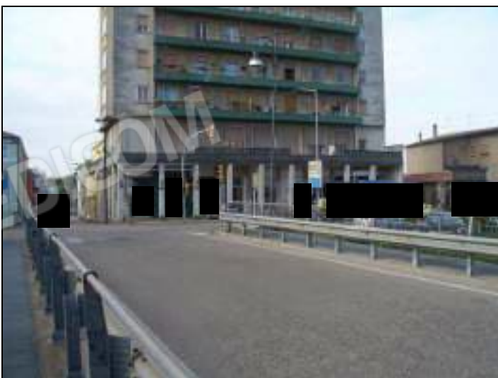
Vista esterna complesso condominiale
