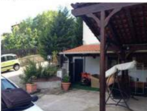
Foto ritraente parte della tettoia al piano semint.
