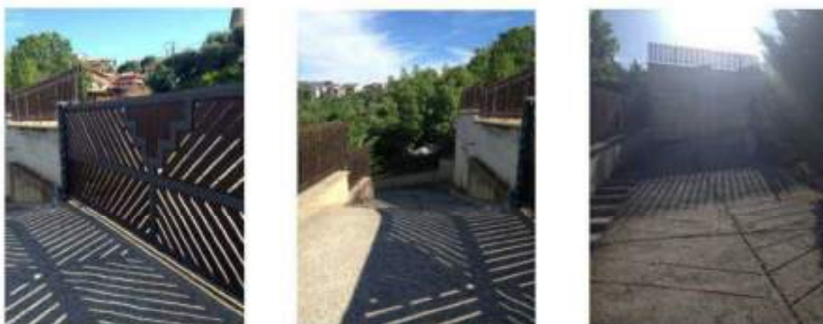
Foto ritratti il cancello d'ingresso e rispettiva rampa d'accesso
