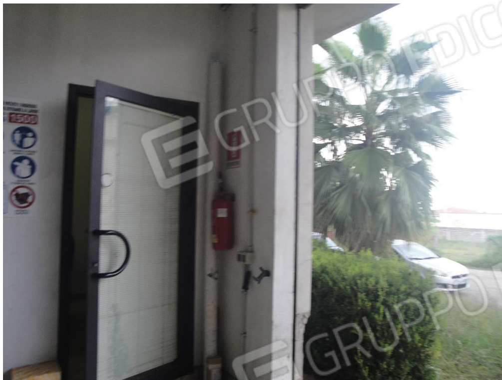
Porta di accesso al vano adibito ad ufficio
