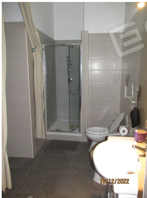
Fotografia 26 – Bagno 2: La pavimentazione è costituita per tutta la sua superficie da piastrelle in gres porcellanato; le pareti sono rivestite con piastrelle di ceramica smaltata fino ad un’altezza di ml 2,20 dal piano di calpestio, mentre la restante parte risulta rivestita con intonaci ordinari a finitura liscia tinteggiate con pittura lavabile.
