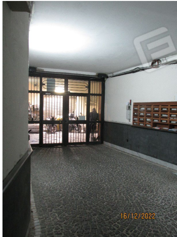
Fotografia 10 – La pavimentazione dell’androne è costituita da cubetti in porfido; le pareti sono rivestite con lastre in marmo per un’altezza di circa ml. 0,60 dal piano di calpestio, mentre per la restante parte sono rivestite con intonaci ordinari, tinteggiate con pittura al quarzo.
