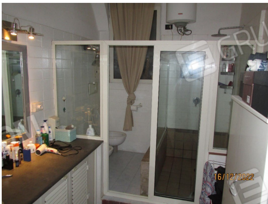
Fotografia 38 – Bagno 1: le pareti sono rivestite con piastrelle di ceramica smaltata fino ad un’altezza di ml 2,20 dal piano di calpestio, mentre la restante parte risulta rivestita con intonaci ordinari a finitura liscia tinteggiate con pittura lavabile; il soffitto risulta interamente rivestito con intonaci ordinari a finitura liscia tinteggiato con pittura a tempera. L’ambiente è dotato di un finestrone da cui prende aria e luce, esposto ad est con affaccio sul vano scala condominiale, il finestrone è dotato di serramento interno in alluminio e vetro camera mentre all’esterno è protetto da una grata in ferro.
