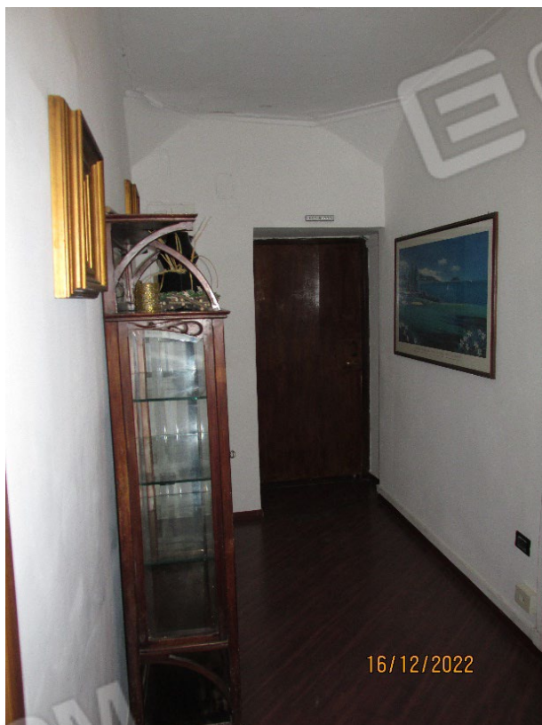
Fotografia 22 – Ingresso : le pareti sono rivestite con intonaci ordinari a finitura liscia e tinteggiate con pittura lavabile; il soffitto è rivestito anch'esso con intonaci ordinari a finitura liscia, ma tinteggiato con pittura a tempera.
