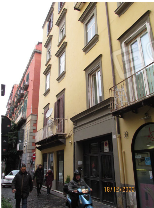
Fotografia 6 – Vista fabbricato da Via Alabardieri.
