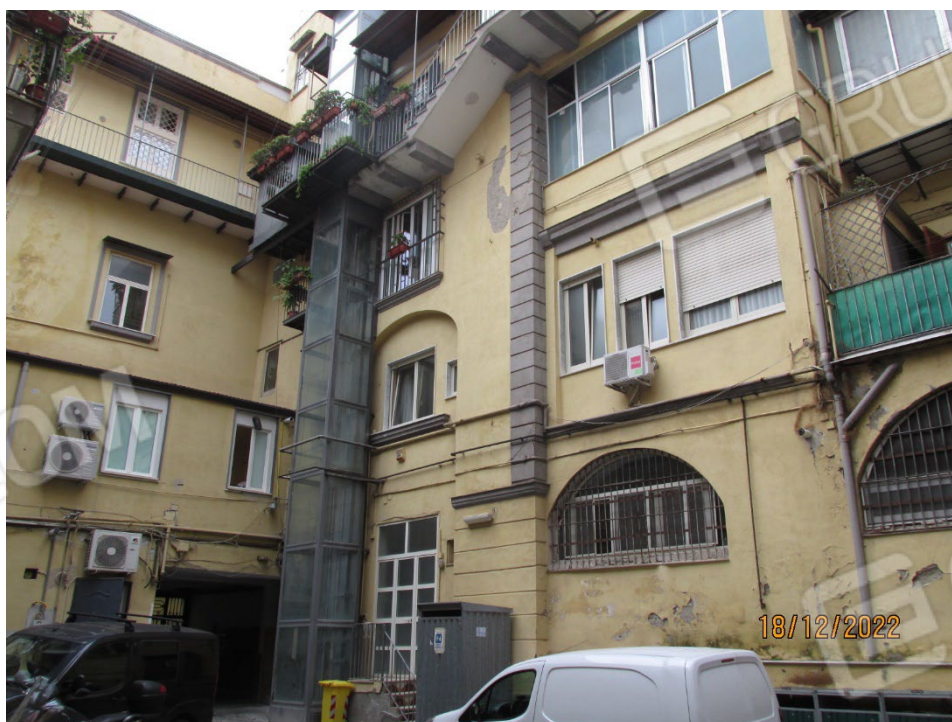
Fotografia 18 – La palazzina in cui insiste l'appartamento pignorato, è dotata di ascensore per la salita ai piani superiori, con fermata sui pianerottoli di riposo per la salita ai piani superiori, con fermata sui pianerottoli di riposo di ogni interpiano poiché probabilmente integrata successivamente alla realizzazione del fabbricato.
