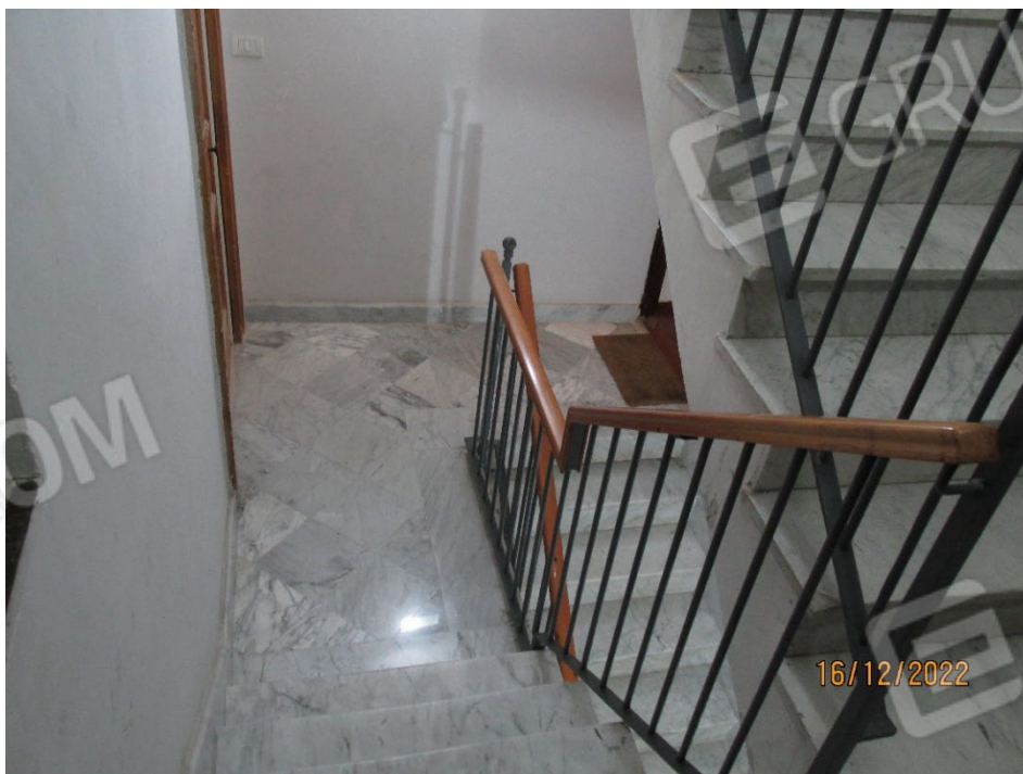
Fotografia 16 – La scala condominiale è costituita da rampanti con gradini rivestiti in lastre di marmo bianco con venature grigio, muniti di ringhiera in ferro con passamani in legno, collegati a ballatoi intermedi e a pianerottoli di accesso agli appartamenti.
