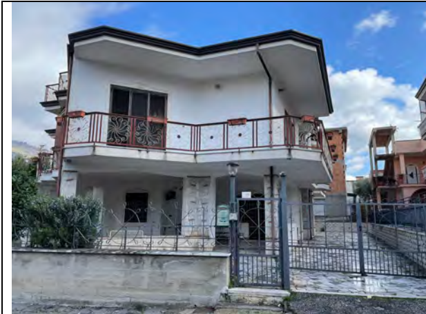
Fotografia n. 1 _ Prospetto su via Camellara
