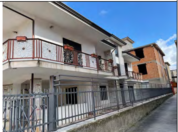
Fotografia n. 4 _ Prospetto sud, vista ovest/est
