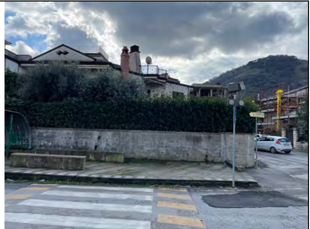
Fotografia n. 2 _ Prospetto su via Cappuccini
