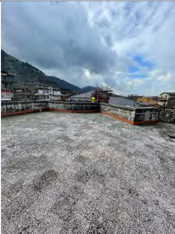
Fotografia n. 9 _ Terrazzo ovest all'ultimo piano
