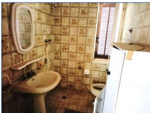
Fotografia 11 – WC piano primo
