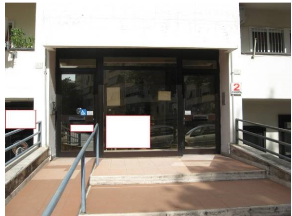
Figura 4 accesso pedonale da via delle Querce n.60/62 in Caserta
