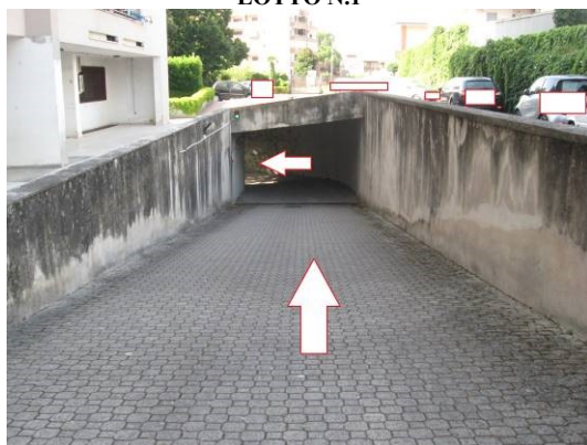
Figura 8 accesso dalla rampa carrabile comune
