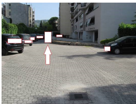
Figura 7 cortile comune per accesso alla rampa carrabile che conduce al piano interrato in cui è posto il LOTTO N.1
