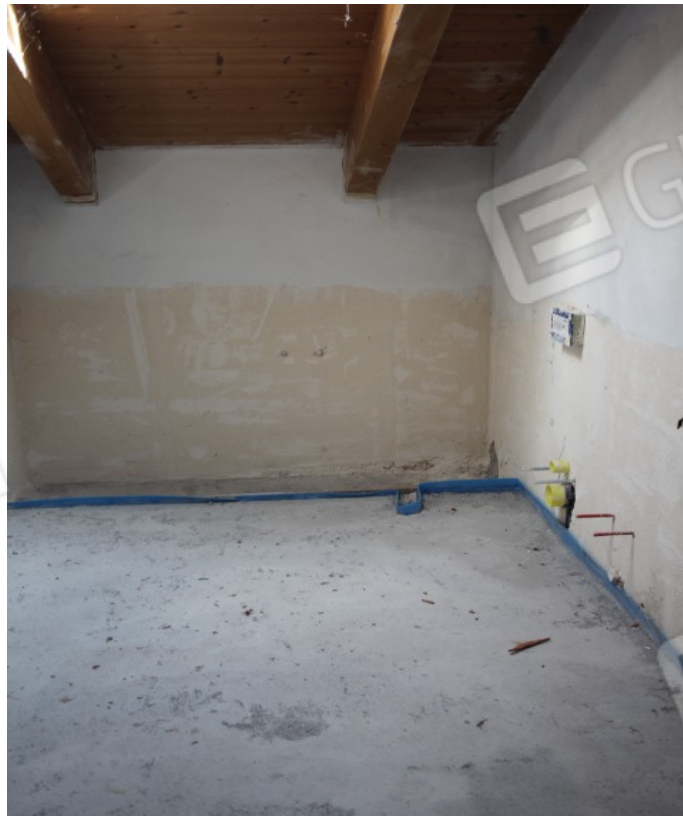
bagno nel sottotetto
