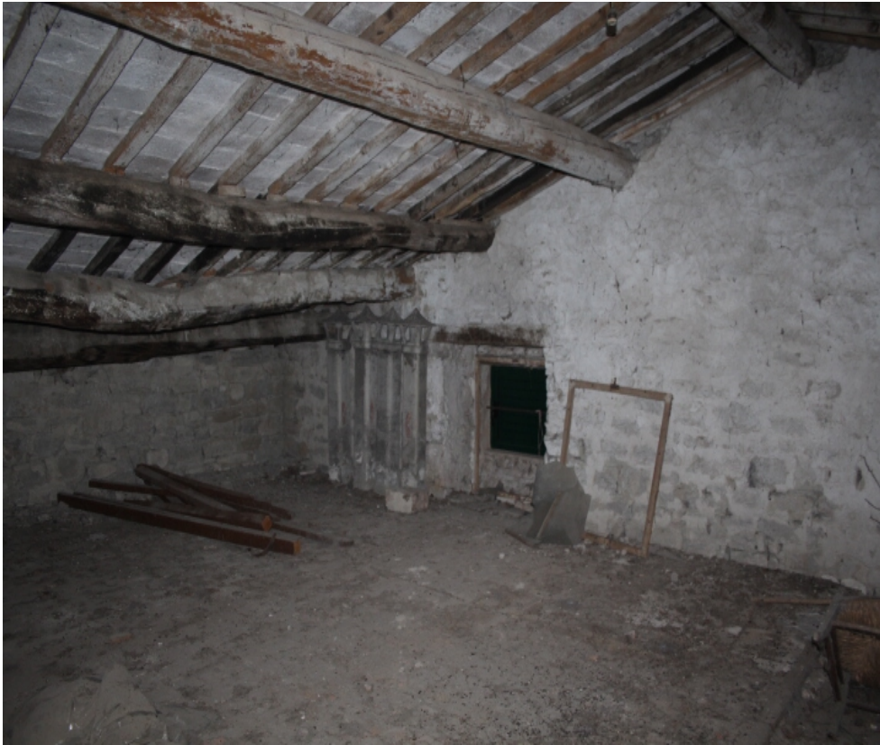
vista interna soffitta
