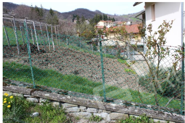
PUNTO DI ATTRAVERSAMENTO IN ALTRA PROPRIETA' DELLA TUBAZIONE ACQUA
