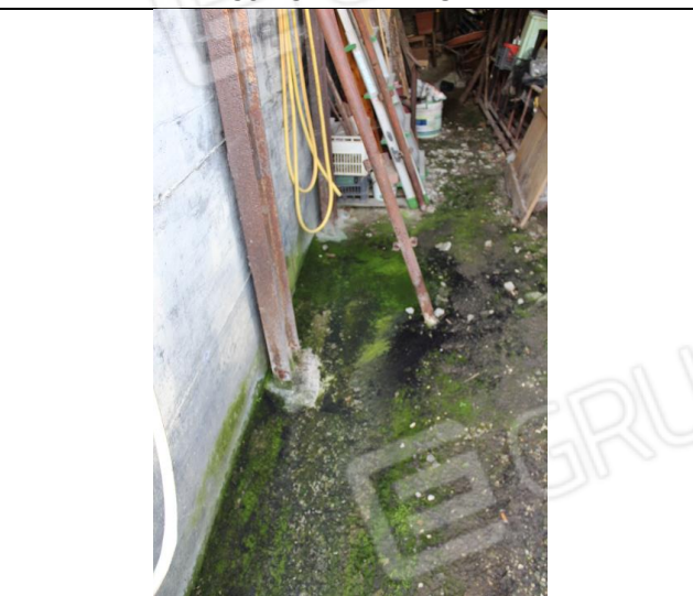
PARTICOLARE STRUTTURA PORTANTE IN FERRO
