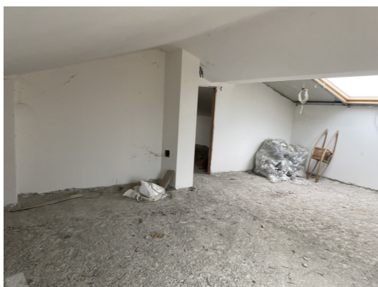
Foto 8: Ripostiglio al grezzo_P.Sottotetto
