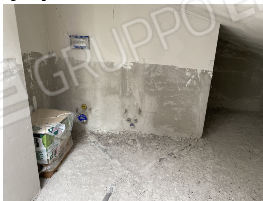
Foto 9: C.T. al grezzo con attacco sanitari_P.Sottotetto
