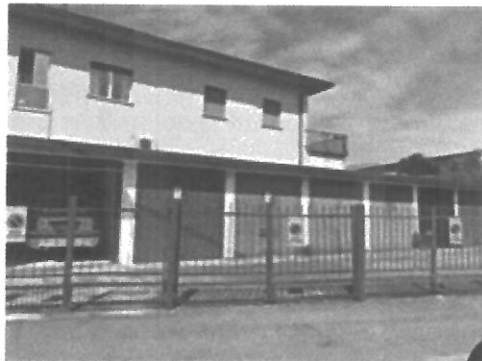
Particolare retro edificio - corpo autorimesse
