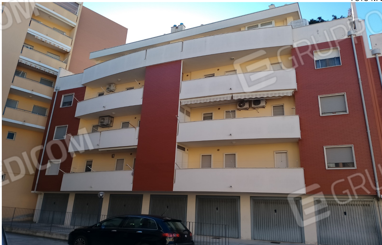
COMUNE DI MATERA STABILE CONDOMINIALE FOGLIO 51 PARTICELLA 2715 - PROSPETTO POSTERIORE
