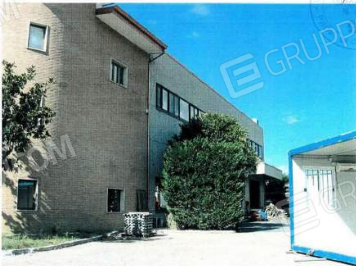
Foto 02 – Cespite n°1: veduta laterale del primo capannone industriale (prospetto ovest visto di scorcio)
