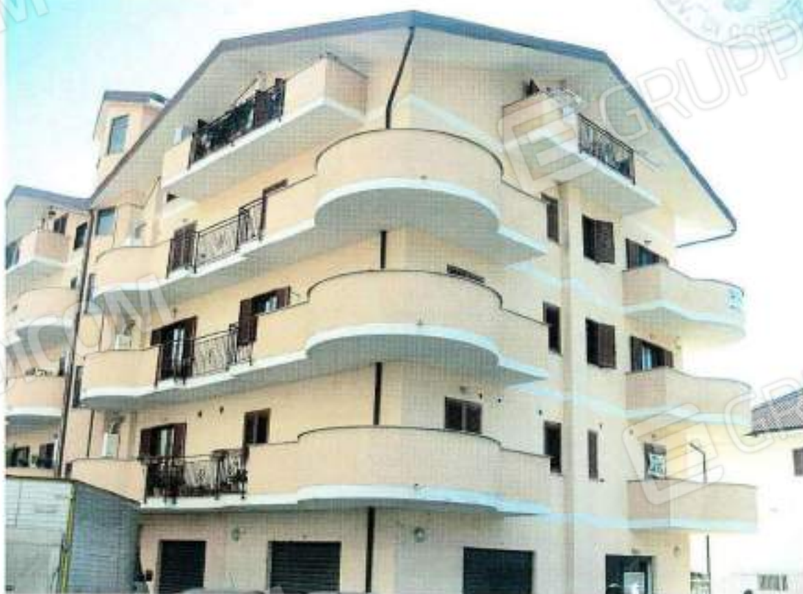
Foto 24 – Cespite n°5: veduta generale del fabbricato al piano primo (prospetti est e sud visti di scorcio)
