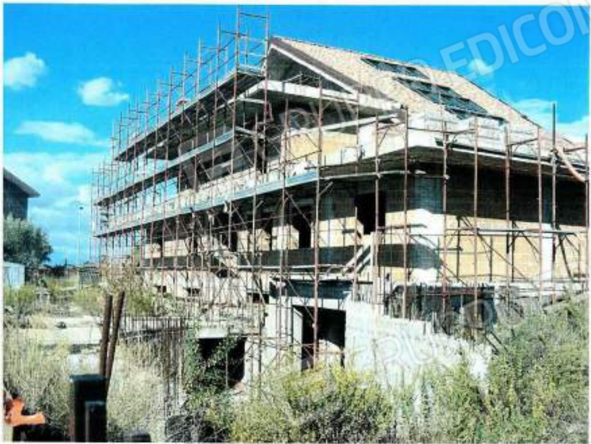
Foto 33 – Cespite n°7: veduta del fabbricato in costruzione in Località Collina Salemi (facciata ovest vista di scorcio)
