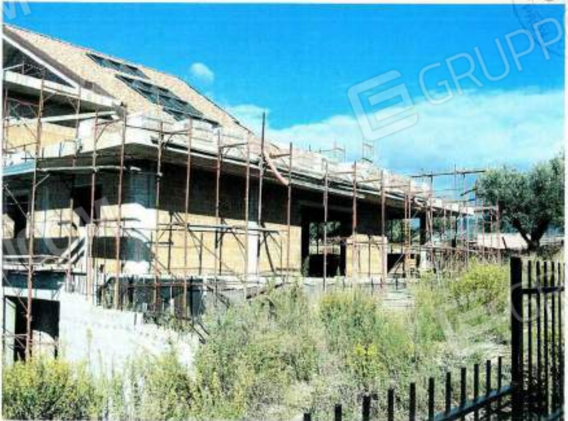
Foto 34 – Cespite n°7: veduta del fabbricato in costruzione in Località Collina Salemi (facciata sud vista di scorcio)
