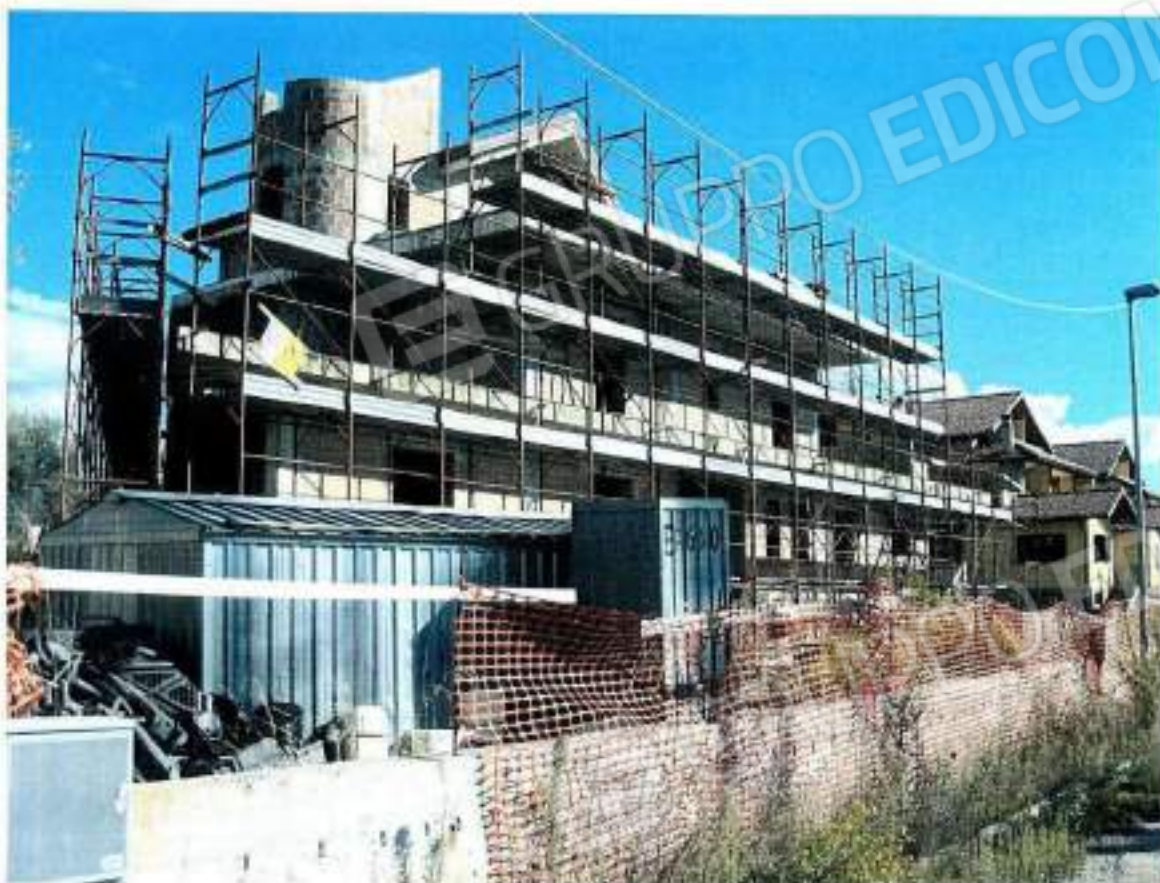
Foto 31 – Cespite n°7: veduta del fabbricato in costruzione in Località Collina Salerno (facciata ovest vista di scorcio)
