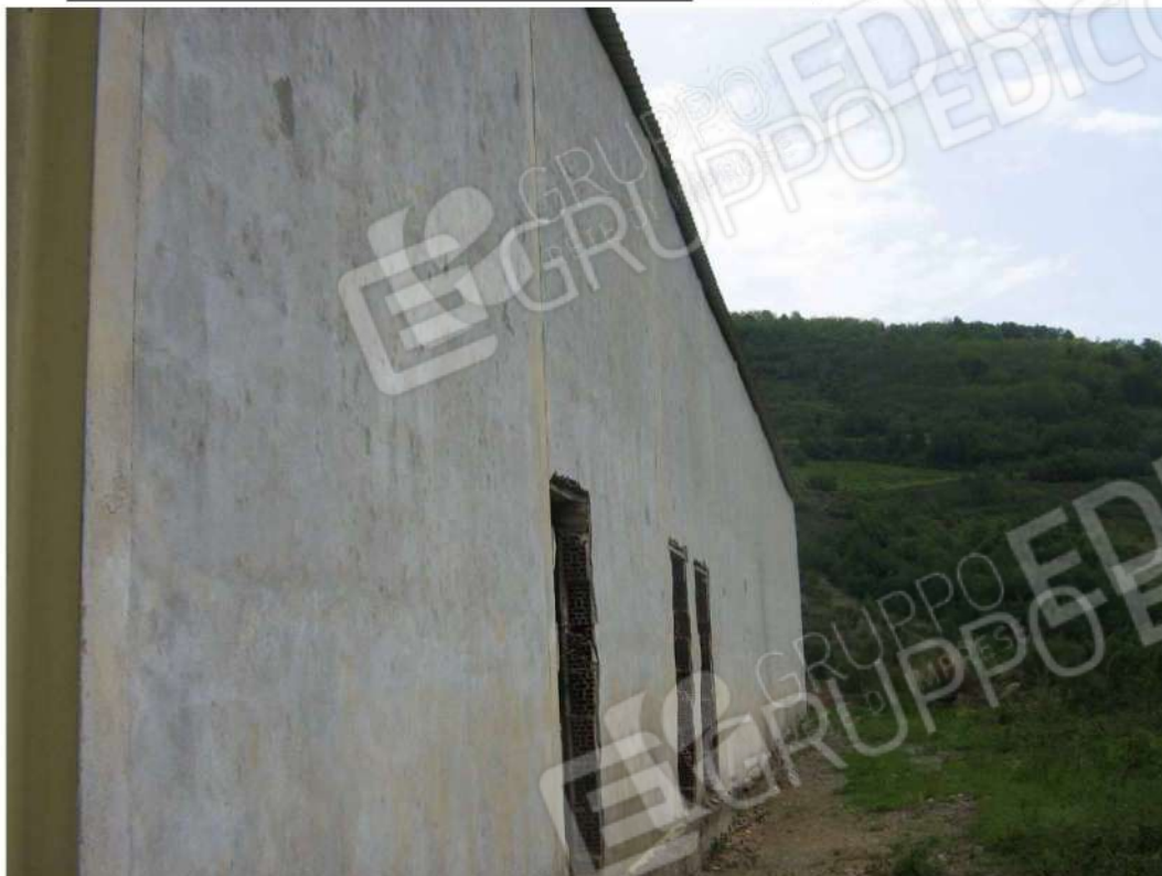
Foto n. 101: prospetto Ovest-Sud-Ovest - Fabbricato "F" (lotto n. 3).
