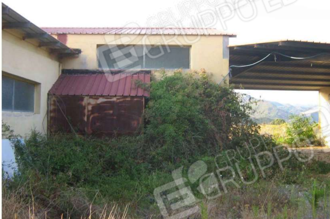
Foto n. 125: prospetto Sud - Fabbricato "H" (lotto n. 3).
