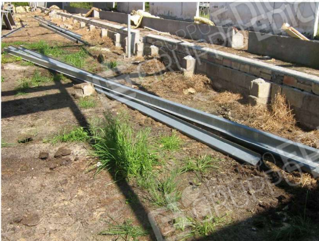
Foto n. 97: particolare arcarecci rimossi dalla struttura di copertura - foto scattata in data 2 maggio 2008 - Fabbricato "E" (lotto n. 4).
