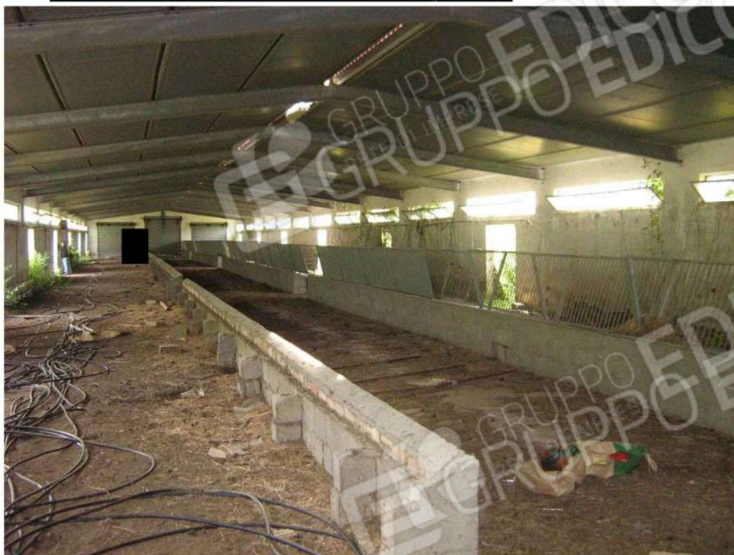
Foto n. 139: ambiente interno del fabbricato "I" (lotto n. 3).
