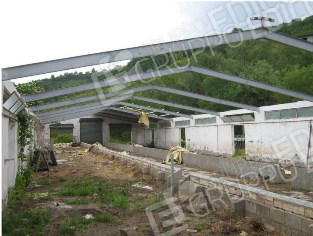
Foto n. 89: particolare ambiente interno e struttura di copertura - Fabbricato "E" (lotto n. 4).
