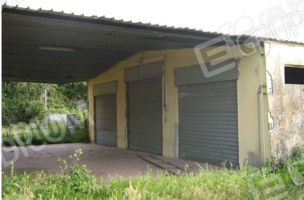
Foto n. 122: prospetto Est-Nord-Est del fabbricato “G” (lotto n. 3).
