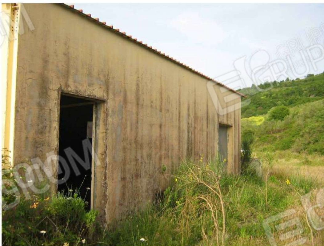
Foto n. 128: foto prospettica fabbricato "H" (lotto n. 3).
