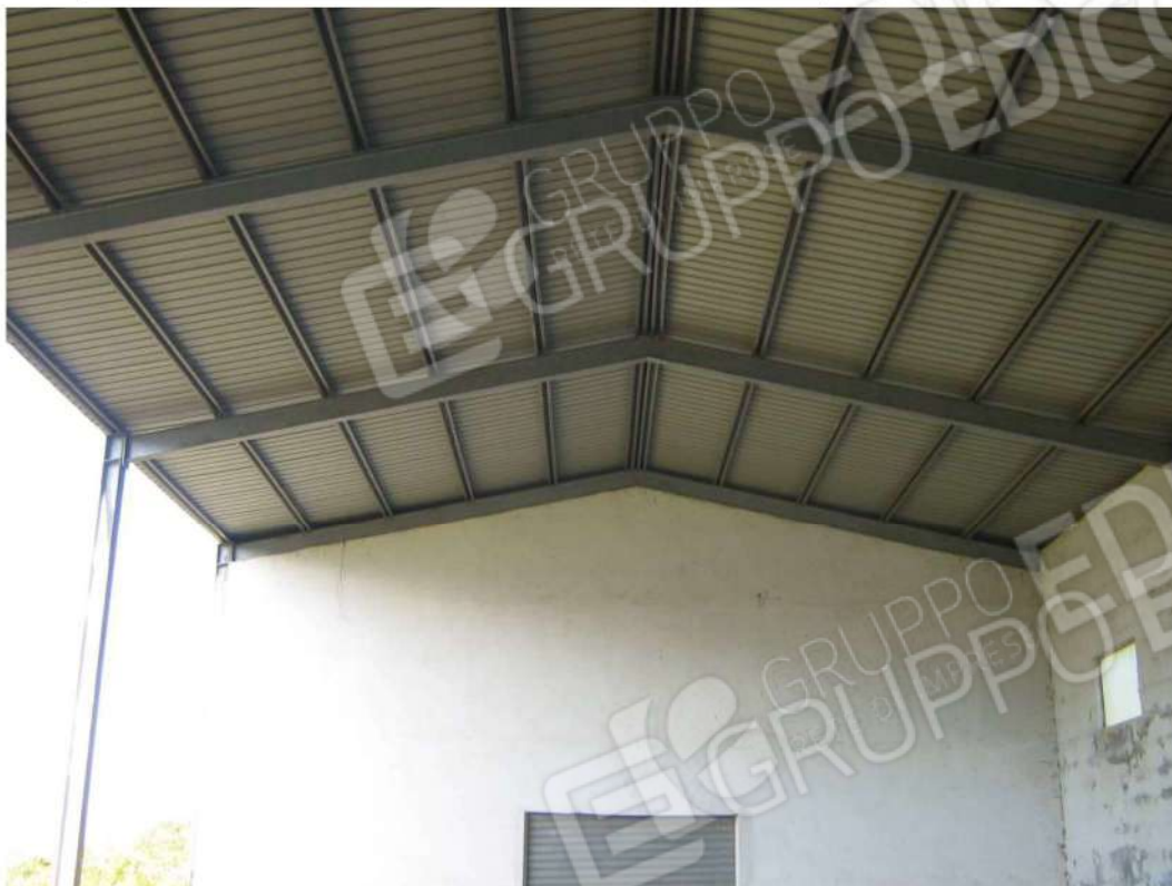
Foto n. 77: particolare struttura di copertura del corpo centrale - Fabbricato "D" (lotto n. 4).
