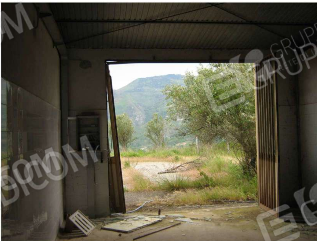
Foto n. 68: particolare ingresso lato Nord-Nord-Ovest - Fabbricato "C" (lotto n. 4).
