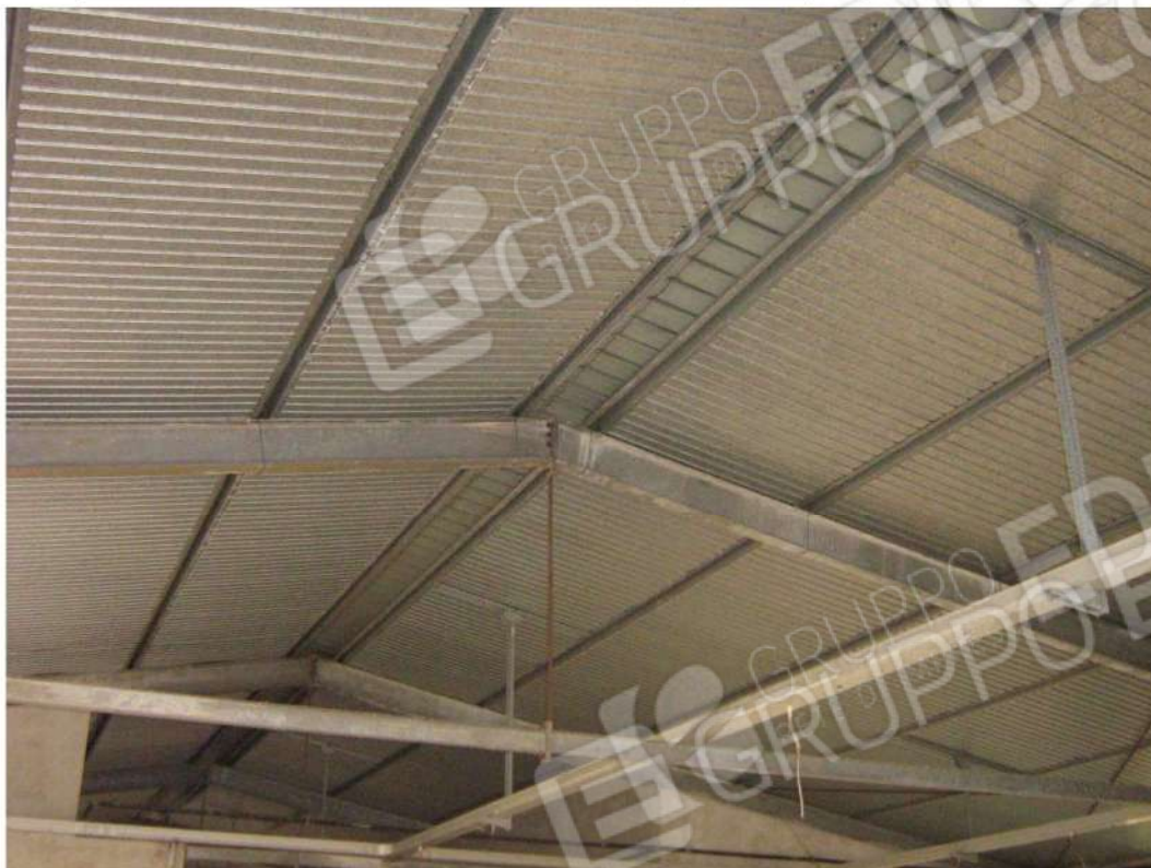
Foto n. 65: particolare struttura di copertura - Fabbricato "C" (lotto n. 4).
