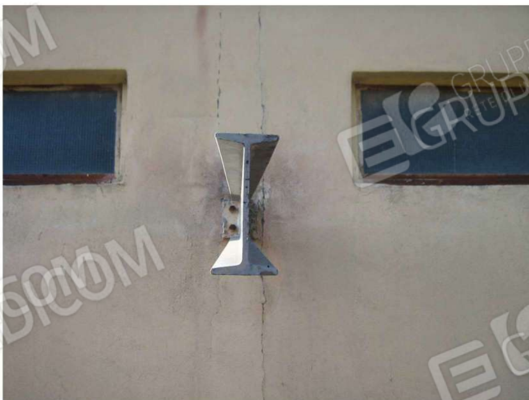
Foto n. 134: particolare della trave a mensola che avrebbe dovuto sostenere la copertura lungo il perimetro del fabbricato "I" (lotto n. 3).
