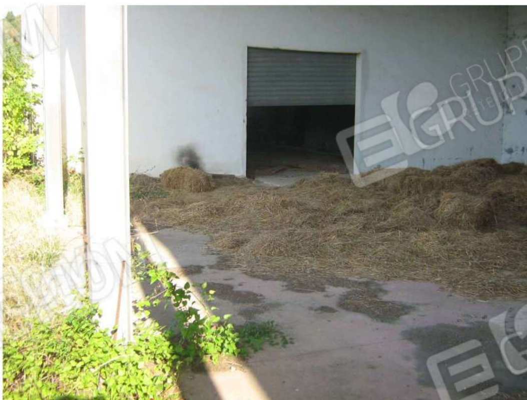
Foto n. 76: particolare corpo centrale adibito a deposito di fieno - Fabbricato "D" (lotto n. 4).
