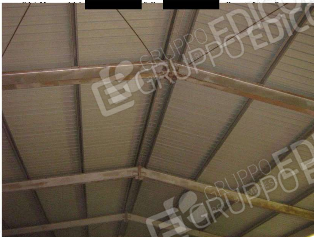
Foto n. 47: particolare struttura di copertura - Fabbricato "B" (lotto n. 4).
