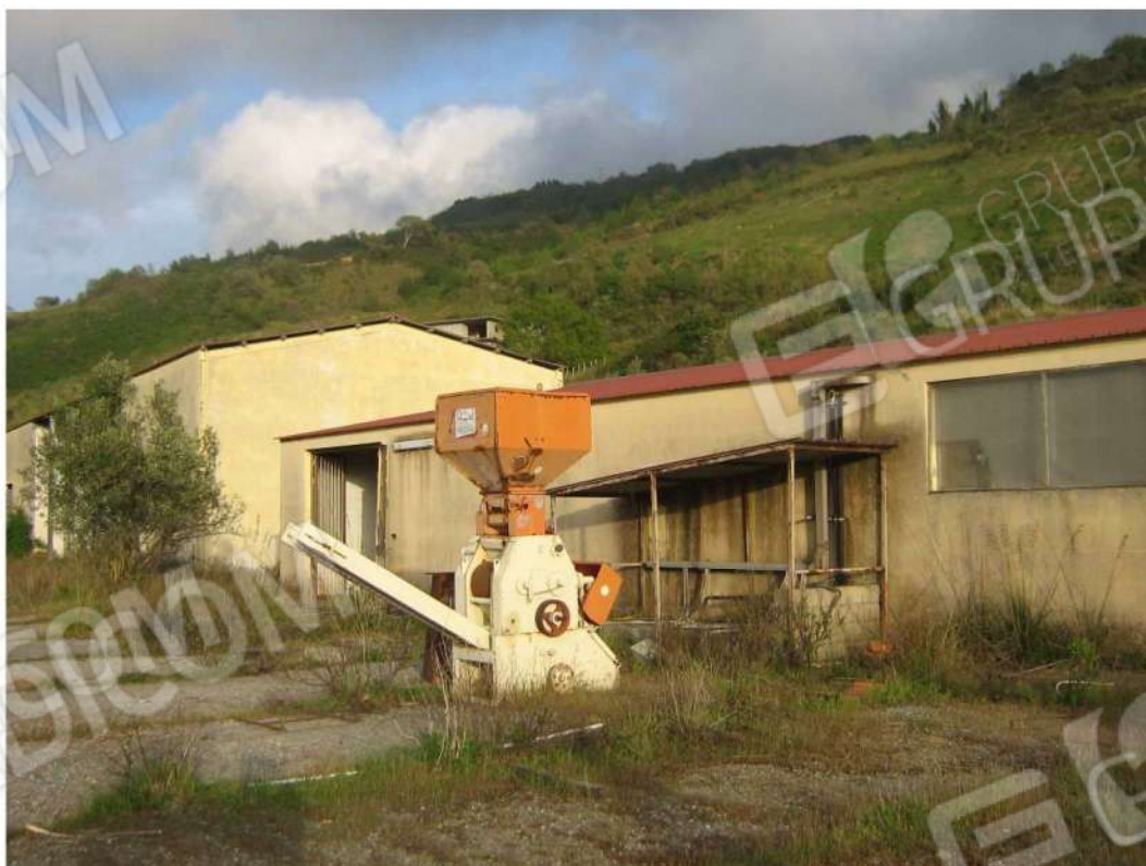
Foto n. 52: foto prospettica del fabbricato "C" (lotto n. 4); da notare la presenza di un macchinario posto all'esterno.
