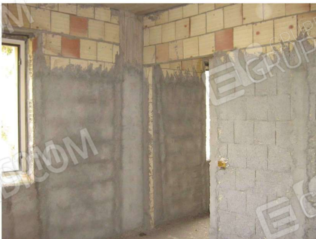
Foto n. 28: particolare tamponatura parzialmente intonacata (solo strato rustico) - Fabbricato "A" (lotto n. 4).
