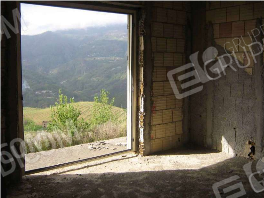
Foto n. 40: foto panoramica del fondo Pacileo/S.I.A.M. scattata dal primo piano del fabbricato "A" (lotto n. 4).
