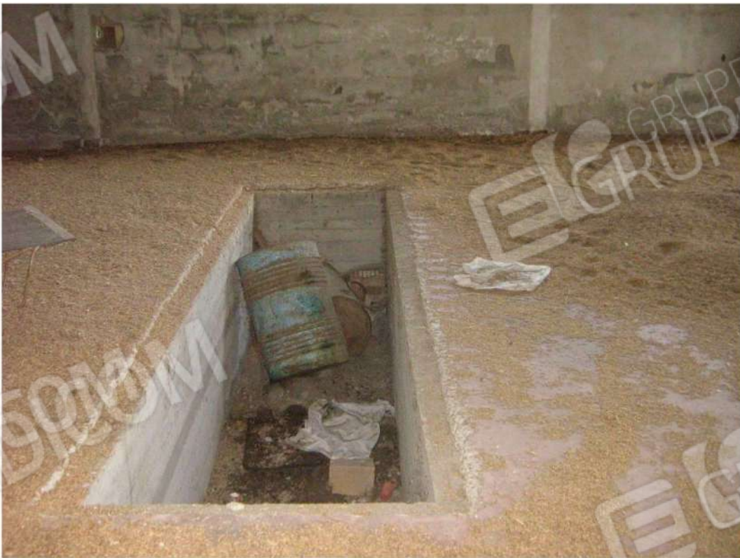
Foto n. 50: particolare fosso di ispezione macchine - Fabbricato "B" (lotto n. 4).
