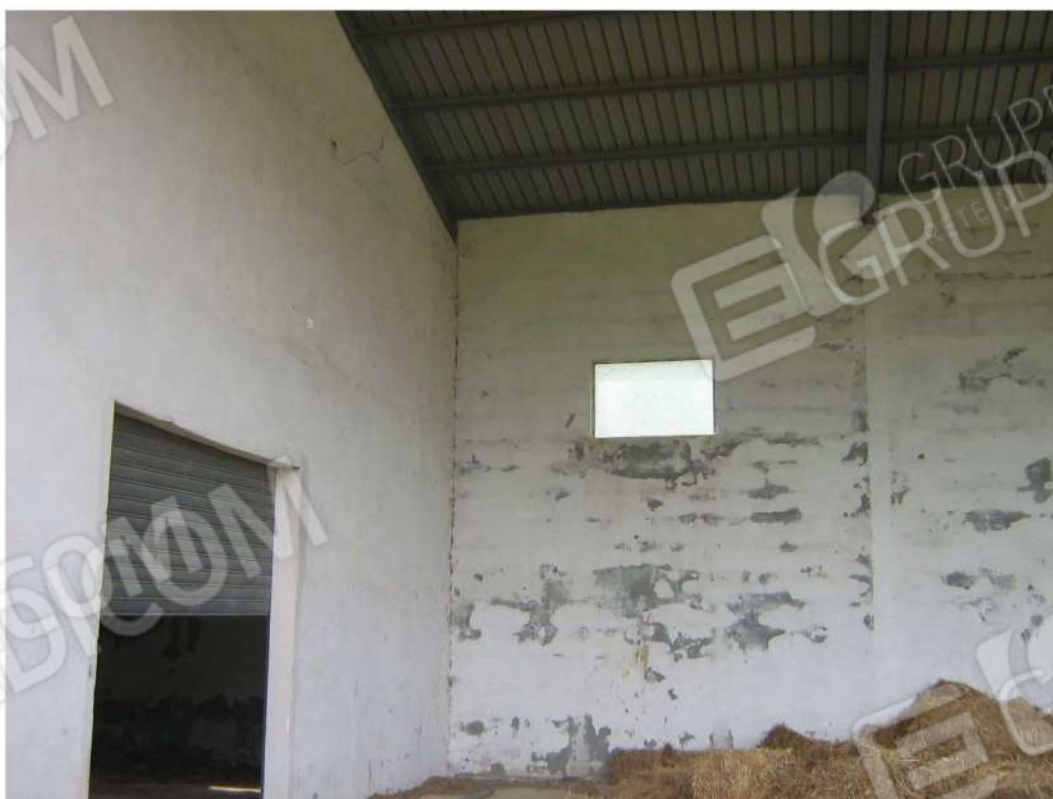
Foto n. 74: particolare ingresso del corpo lato Est-Nord-Est - Fabbricato "D" (lotto n. 4).
