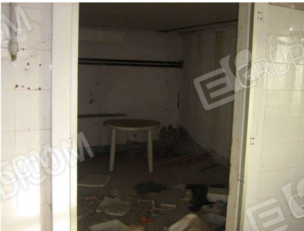
Foto n. 62: particolare vano interno - Fabbricato "C" (lotto n. 4).
