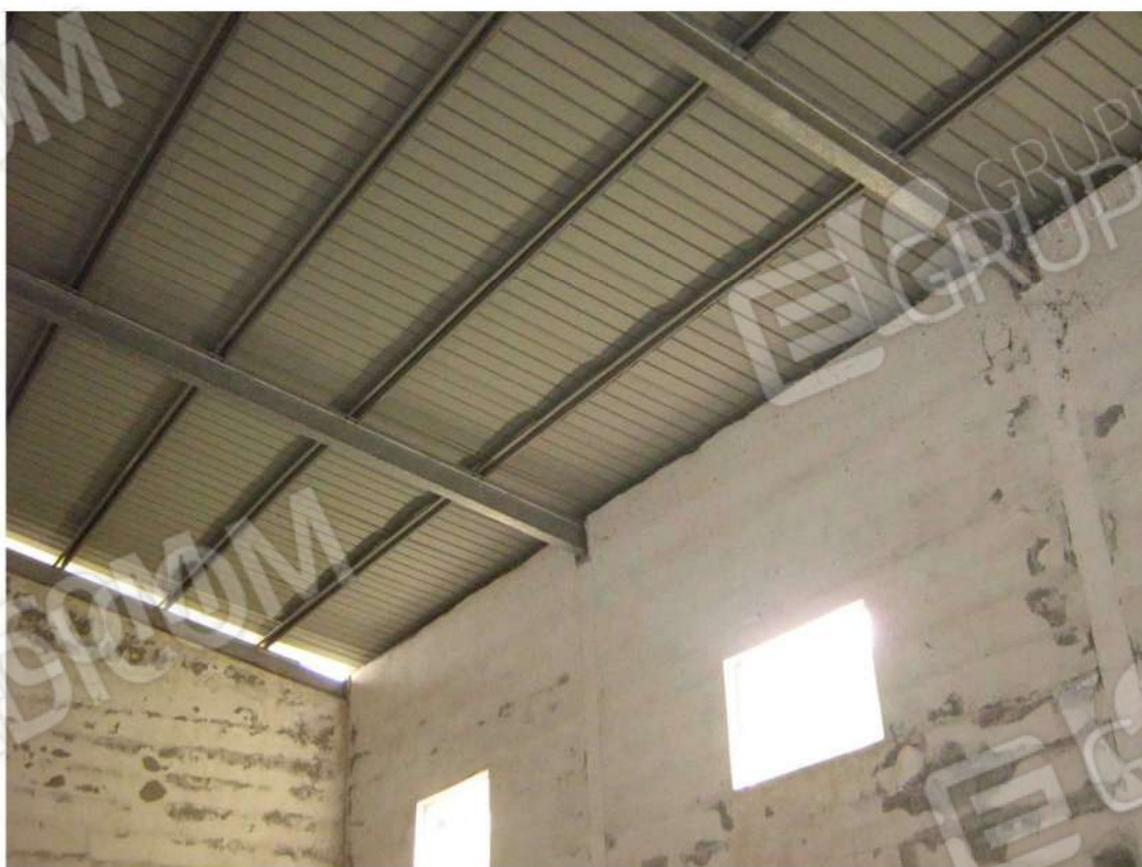
Foto n. 78: particolare appoggio della struttura di copertura sulle pareti perimetrali - Fabbricato "D" (lotto n. 4).
