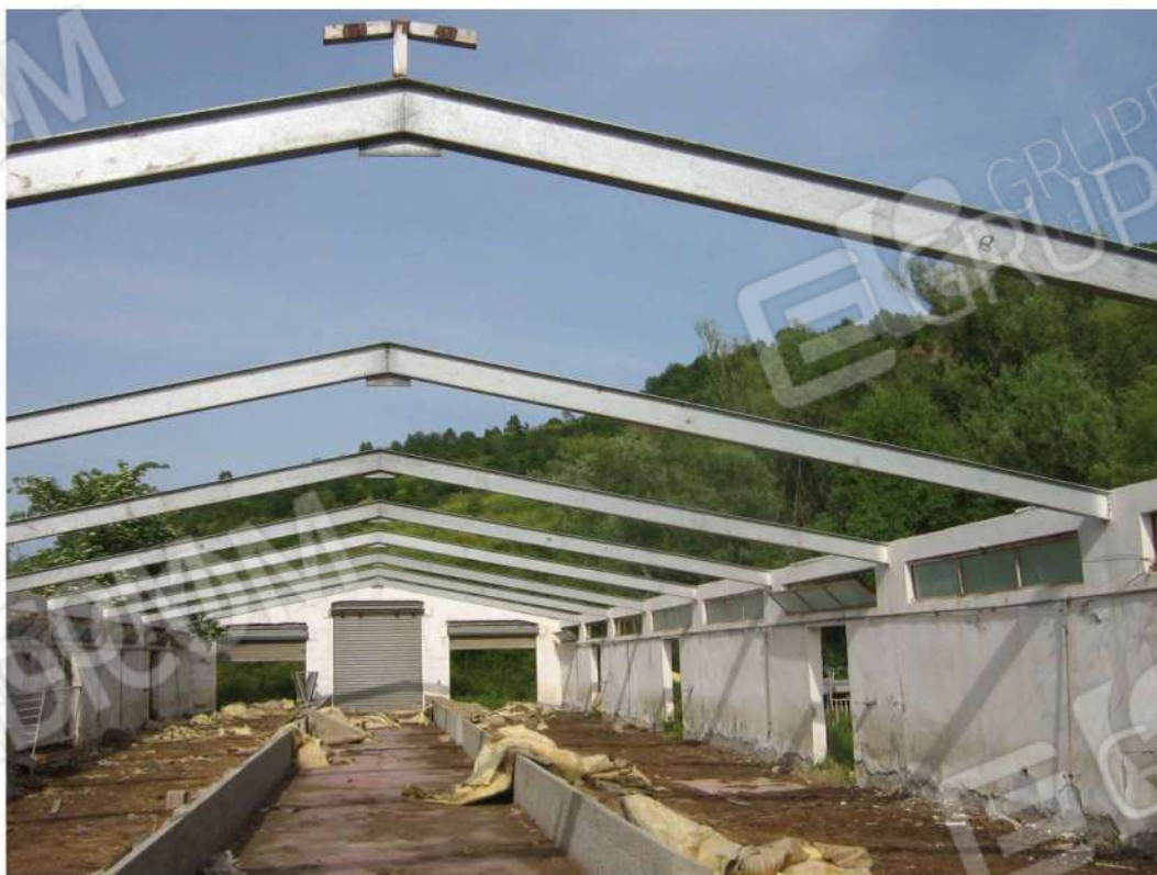
Foto n. 90: particolare ambiente interno e struttura di copertura - Fabbricato "E" (lotto n. 4).
