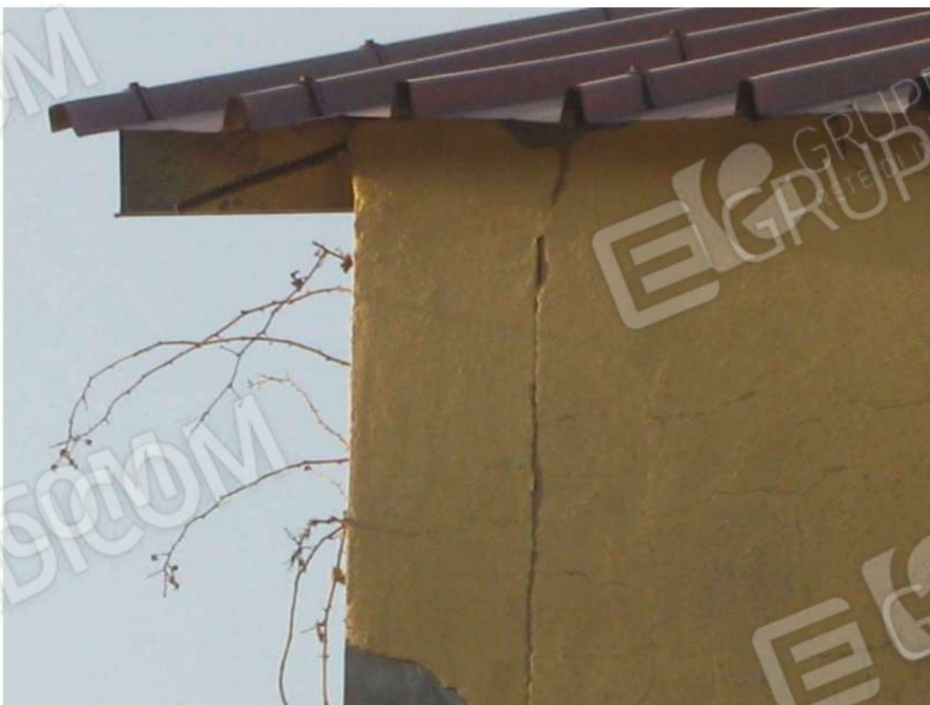
Foto n. 132: particolare struttura di copertura fabbricato "H" - da notare la lesione verticale presente fra la tamponatura e il pilastro portante in acciaio (lotto n. 3).
