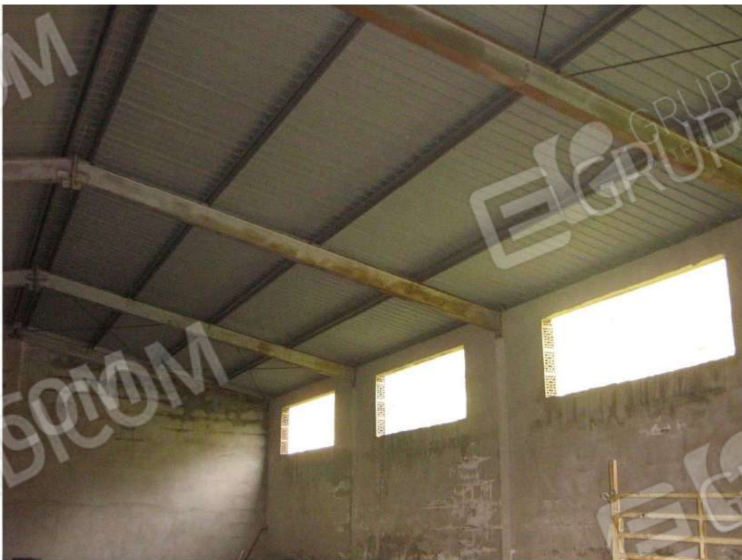
Foto n. 48: particolare falda di copertura lato Sud-Est - Fabbricato "B" (lotto n. 4).
