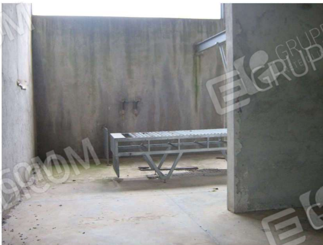
Foto n. 108: particolare tompagnatura - Fabbricato "F" (lotto n. 3).
