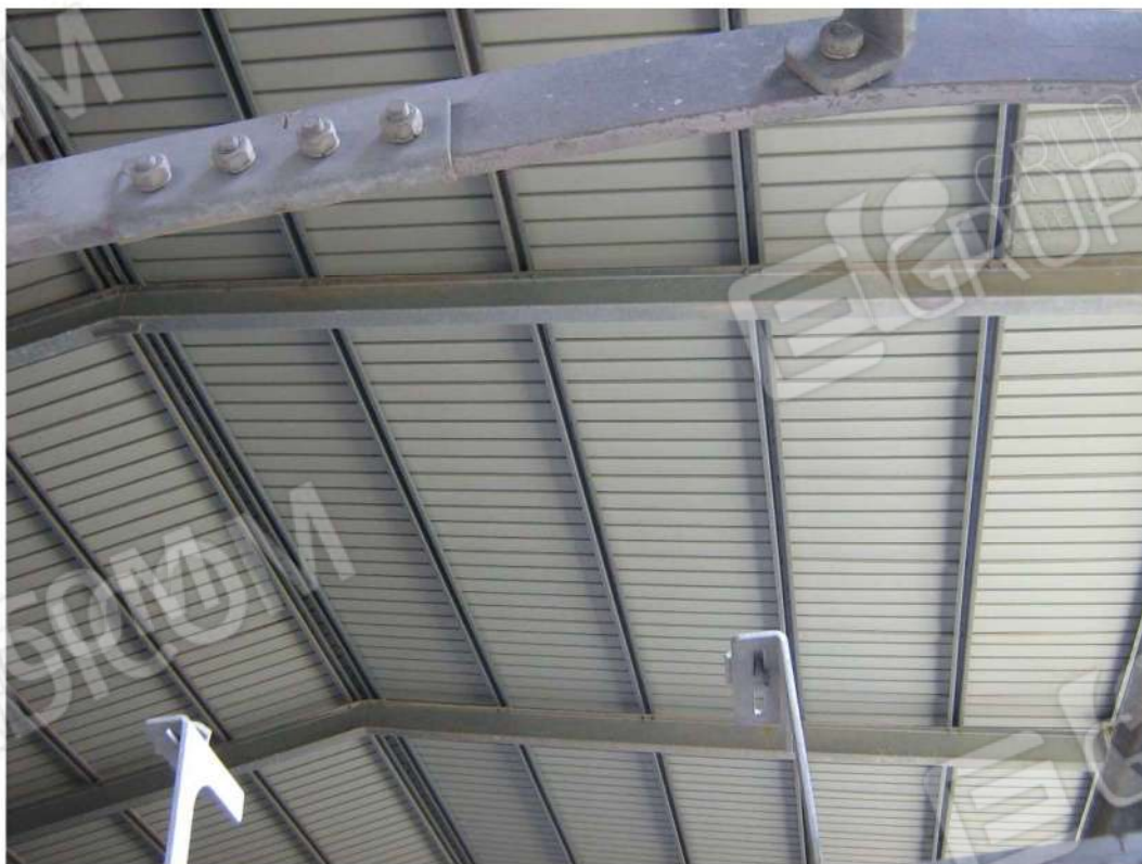
Foto n. 114: particolare struttura di copertura - Fabbricato "F" (lotto n. 3).
