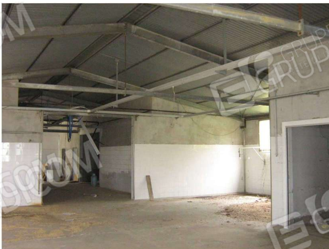
Foto n. 56: particolare ambiente interno - Fabbricato "C" (lotto n. 4).
