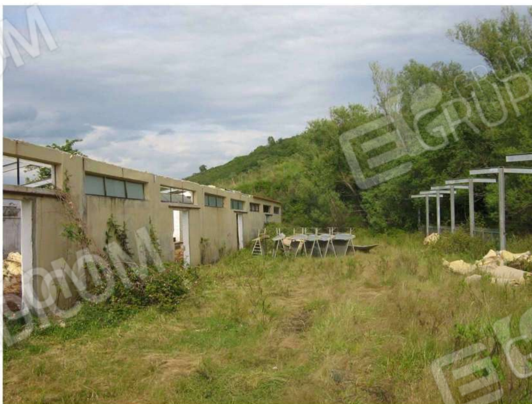
Foto n. 82: prospetto Sud-Sud-Est - Fabbricato “E” (lotto n. 4).
