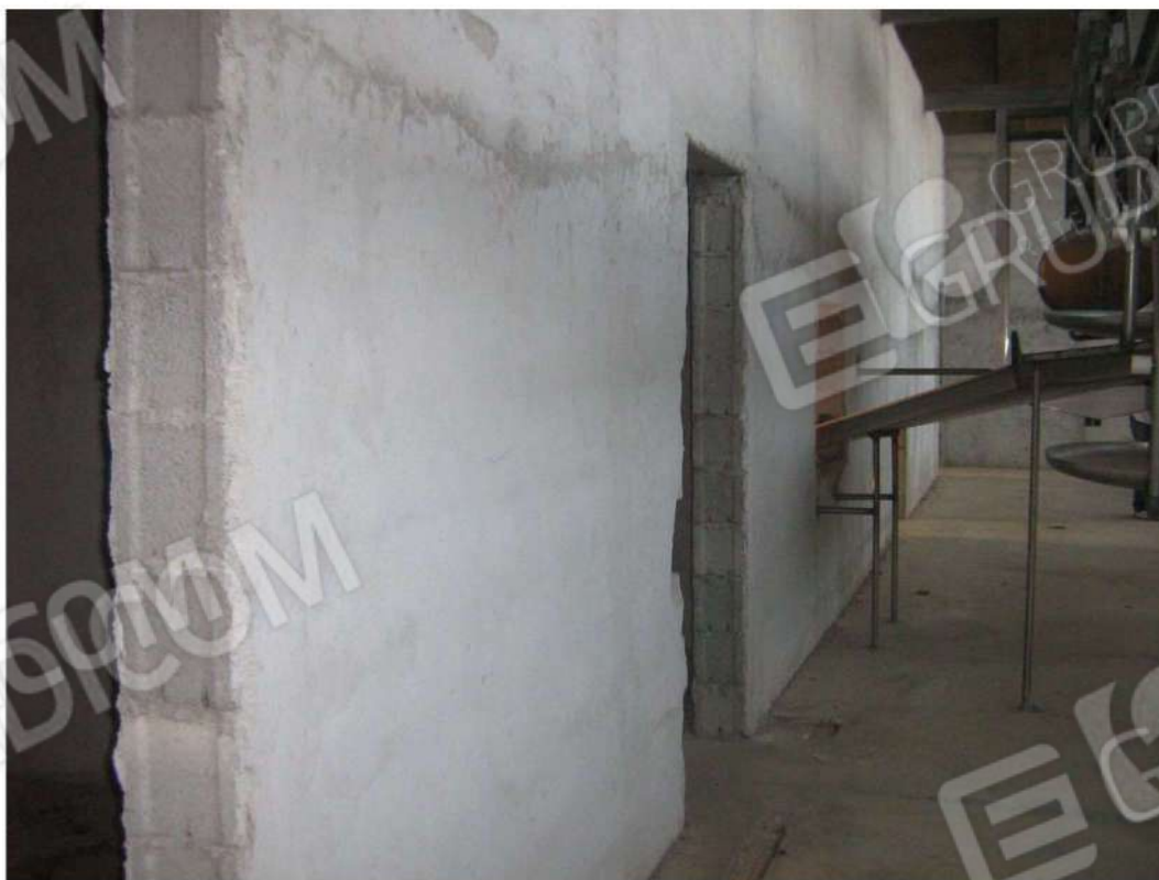
Foto n. 106: particolare tamponatura - Fabbricato "F" (lotto n. 3).
