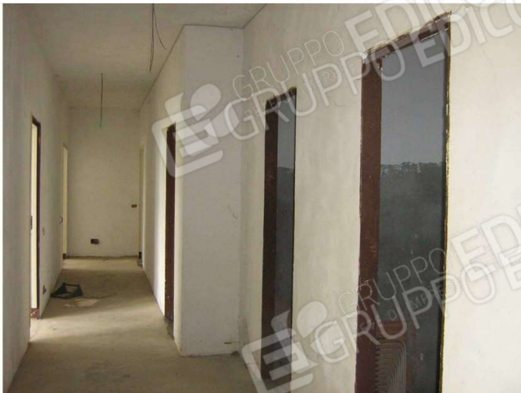
Foto n. 33: particolare corridoio di distribuzione del piano terra – Fabbricato “A” (lotto n. 4).
