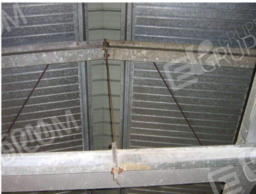
Foto n. 66: particolare struttura di copertura - Fabbricato "C" (lotto n. 4).
