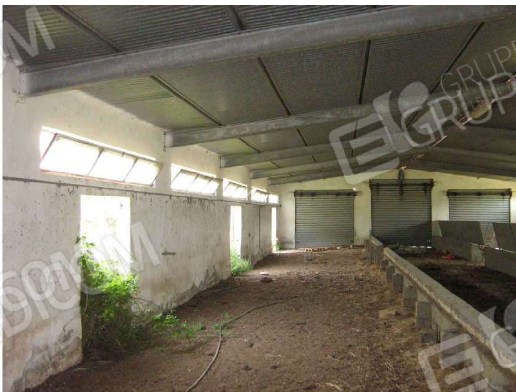
Foto n. 140: ambiente interno del fabbricato "I" (lotto n. 3).
