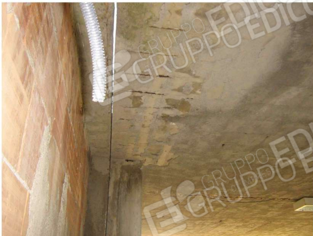
Foto n. 31: particolare del giunto tecnico di connessione tra il corpo principale e il vano scala lato Sud-Ovest - Fabbricato "A" (lotto n. 4).
