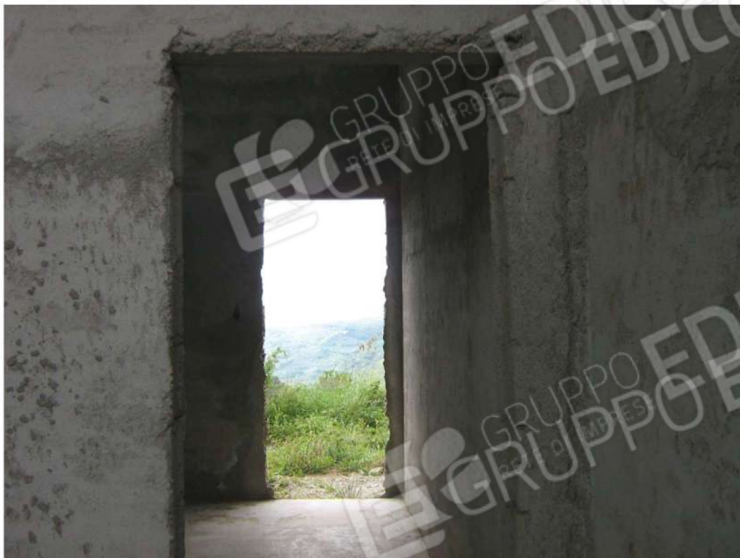
Foto n. 111: particolare ingresso lato mare - Fabbricato "F" (lotto n. 3).
